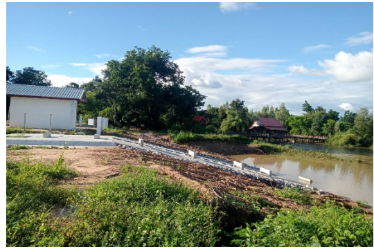
อยู่ระหว่างดำเนินการก่อสร้างสถานีสูบน้ำ
