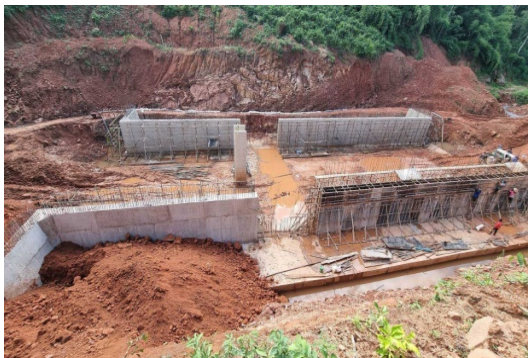
ระหว่างก่อสร้างฝาย
