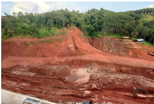
ระหว่างก่อสร้างทำนบดินห้วงงาน
