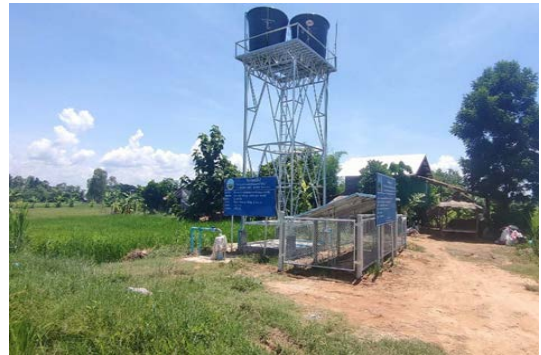
กิจกรรมระบบกระจายน้ำด้วยหอถังสูง
