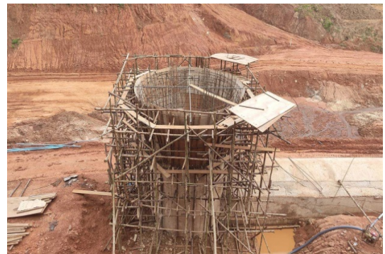
ระหว่างก่อสร้างอาคารระบายน้ำล้น
