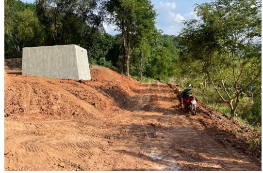
ระหว่างก่อสร้างถังพักน้ำ
