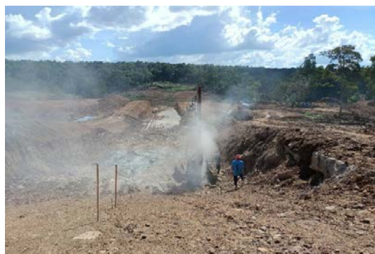
งานขุดร่องแกนและปรับปรุงฐานรากเขื่อน
