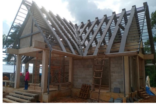
ระหว่างก่อสร้างอาคารที่ทำการป่าไม้ขนาดเล็ก
