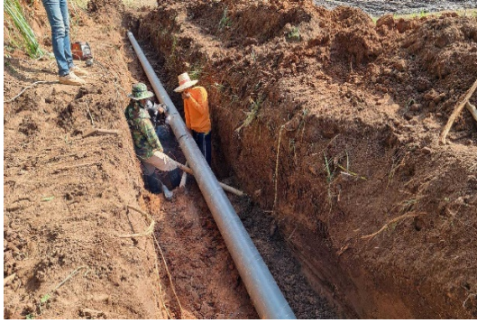
ระหว่างก่อสร้างท่อส่งน้ำ
