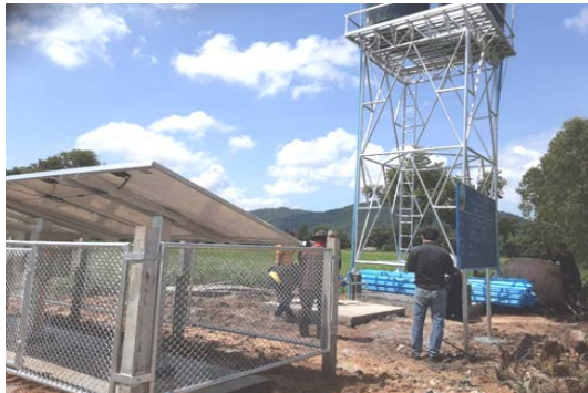
ขุดเจาะบ่อบาดาลสูบน้ำด้วยพลังงานแสงอาทิตย์
