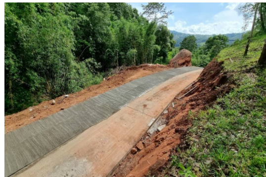
ระหว่างก่อสร้างถนน
