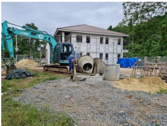
ภาพถ่ายการดำเนินการก่อสร้างอาคารบ้านพัก ๒ ชั้น
