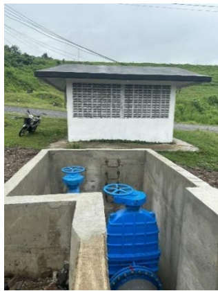
อาคารท่อส่งน้ำจากอ่างเก็บน้ำห้วยหิน
