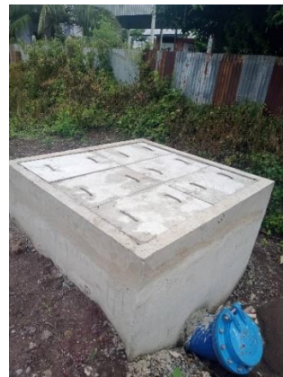
ติดตั้งอาคาร BLOW OFF
