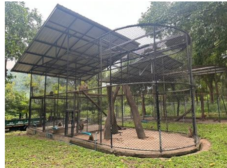
กรงเลี้ยงและชะนีที่ซ่อมแซมแล้วเสร็จ
