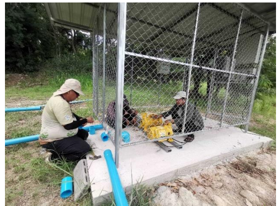
ก่อสร้างโรงสูบน้ำพร้อมติดตั้งเครื่องสูบน้ำ
