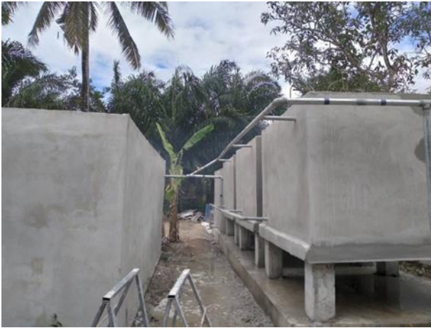
งานถังกรองน้ำและถังเก็บน้ำ ที่ดำเนินการแล้วเสร็จ
