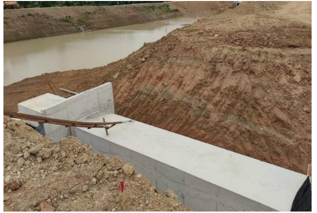
งานอาคารบังคับน้ำ
