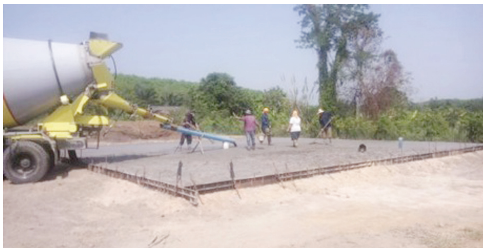
ซ่อมแซมลานผลิตปุ๋ยหมัก
