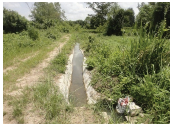
การส่งน้ำโดยใช้ท่อกาลักน้ำ และคูน้ำสำหรับการส่งน้ำให้กับพื้นที่ของหน่วยงานต่างๆ
