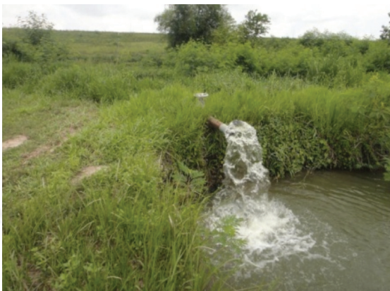
การส่งน้ำโดยใช้ท่อกาลักน้ำ และคูน้ำสำหรับการส่งน้ำให้กับพื้นที่ของหน่วยงานต่างๆ
