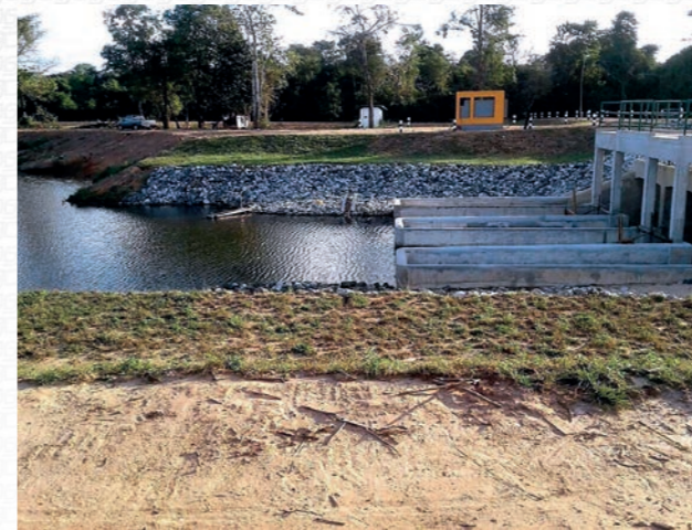
The Huai Yang Weir
