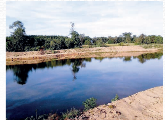
The Site of Huai Yang Creek Dredging
