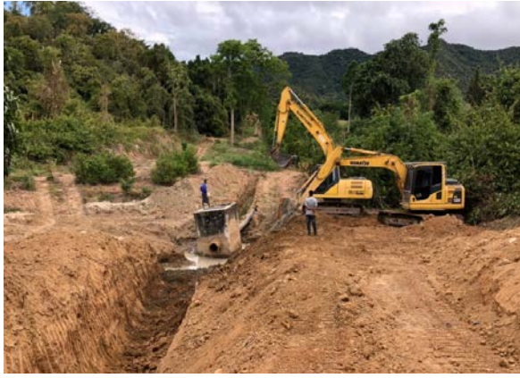
การปรับปรุงท่อส่งน้ำโดยใช้ท่อ H.D.P.E
