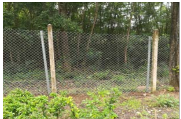
แนวรั้วตาข่ายที่ได้รับการปรับปรุงซ่อมแซม เพื่อแสดงแนวเขตที่ ชัดเจน และป้องกันไม่ให้สัตว์ป่าออกนอกพื้นที่ รวมทั้งป้องกัน การบุกรุก แผ้วถาง ถิ่นครองกรรมสิทธิ์ในที่ดินบริเวณเขาชีโอน
