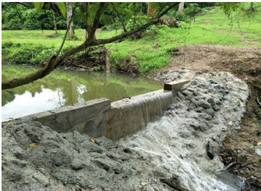
ก่อสร้างฝายต้นน้ำแบบกึ่งถาวร
