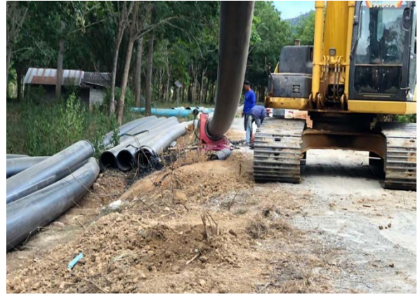
การปรับปรุงท่อส่งน้ำโดยใช้ท่อ H.D.P.E
