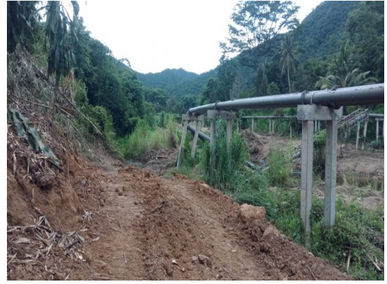
การขุดเปิดพื้นที่เพื่อปรับปรุงระบบท่อส่งน้ำของโครงการฝายหุบเสือโฮกฯ
