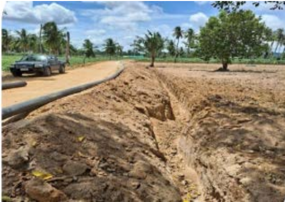
เตรียมพื้นที่เพื่อวางแนวท่อส่งน้ำ
