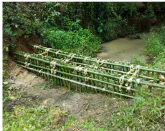
ก่อสร้างฝายต้นน้ำแบบคอกหมู
