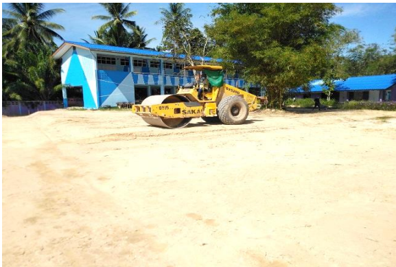
ระหว่างดำเนินการปรับพื้นที่
