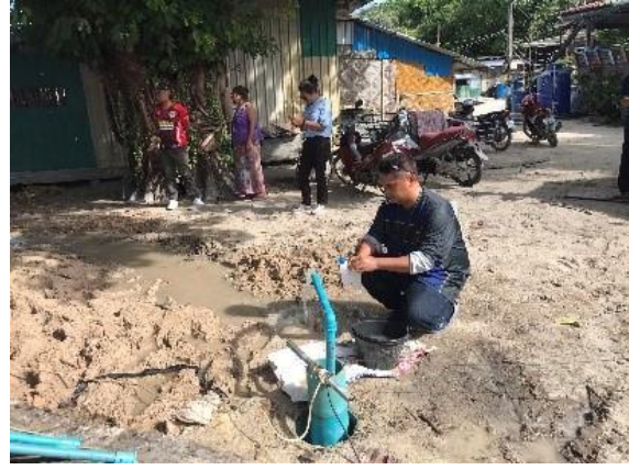
กิจกรรมงานขุดเจาะบ่อบาดาลและกิจกรรมสูบน้ำทดสอบบ่อบาดาล
