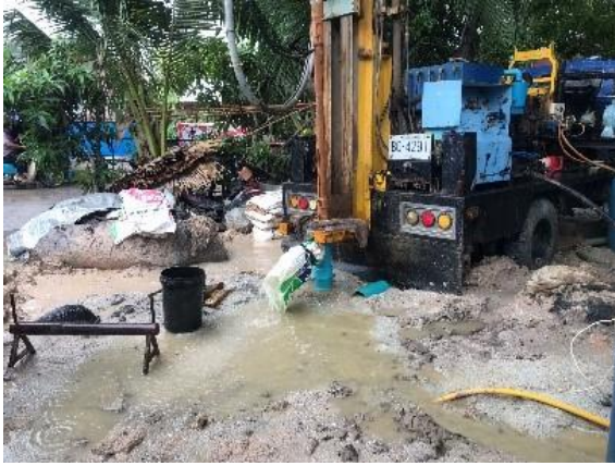
กิจกรรมงานขุดเจาะบ่อบาดาลและกิจกรรมสูบน้ำทดสอบบ่อบาดาล
