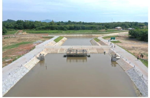
อาคารบังคับน้ำ ๓ ช่องสี่เหลี่ยม ขนาด ๒.๕๐ x ๒.๕๐ เมตร พร้อมท่อปากคลองส่งน้ำ และคันกั้นน้ำ จำนวน ๓ แห่ง
