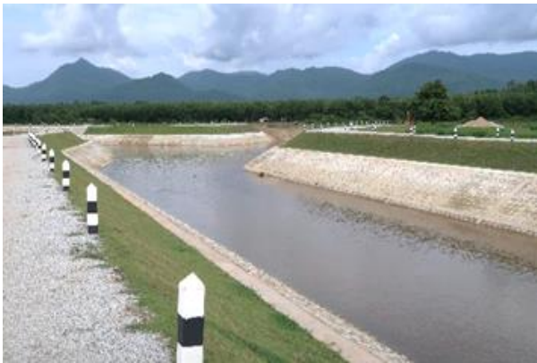
อาคารบังคับน้ำ ๓ ช่องสี่เหลี่ยม ขนาด ๒.๕๐ x ๒.๕๐ เมตร พร้อมท่อปากคลองส่งน้ำ และคันกั้นน้ำ จำนวน ๓ แห่ง
