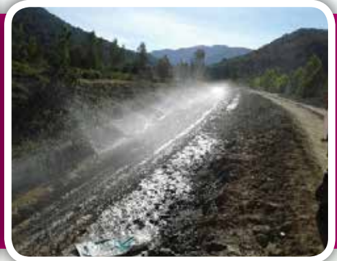
ภาพที่ 4 ปลุกหญ้าแฝกบริเวณฐานยันเขื่อนอ่างเก็บน้ำแม่มานในอันเนื่องมาจากพระราชดำริ จังหวัดลำปาง และวิธีการให้น้ำ
