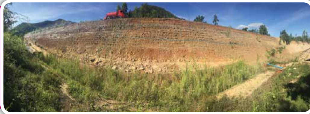
ภาพที่ 4 ปลุกหญ้าแฝกบริเวณฐานยันเขื่อนอ่างเก็บน้ำแม่มานในอันเนื่องมาจากพระราชดำริ จังหวัดลำปาง และวิธีการให้น้ำ
