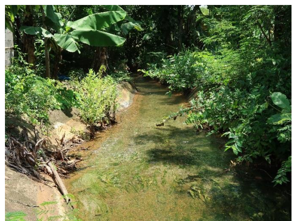
ปรับปรุงคลองส่งน้ำตาดคอนกรีต ความยาว ๑,๔๔๕ เมตร
