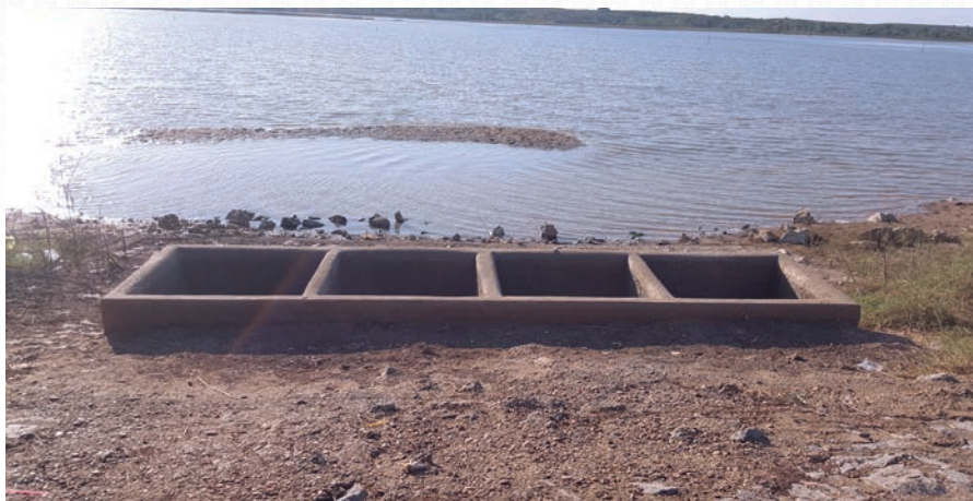
ภาพก่อนดำเนินการ
