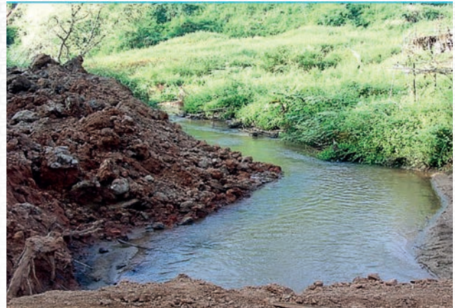
สภาพล้นน้ำเดิมของอ่างเก็บน้ำห้วยมะแกง
