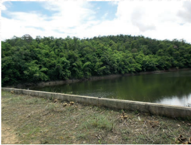
เสริมทำนบดินด้านเหนือน้ำขึ้นประมาณ ๑ เมตร ให้สามารถรองรับปริมาณน้ำที่เพิ่มขึ้นอย่างปลอดภัย
