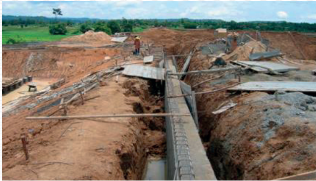
ก่อสร้างทำนบกั้นสูง ๑.๔ เมตร กว้าง ๕ เมตร ยาว ๘๐๕ เมตร พร้อมคลองส่งน้ำ และทางระบายน้ำล้น
