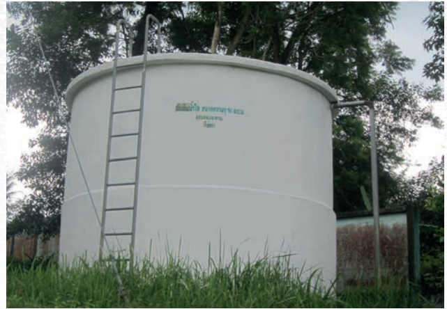
ถังเก็บน้ำ ขนาด ๕๐ ลูกบาศก์เมตร
