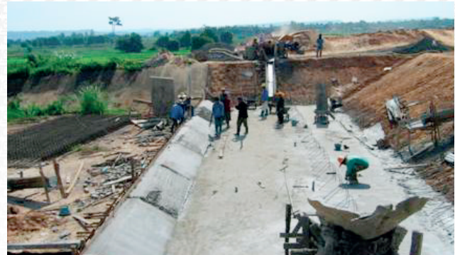
ก่อสร้างทำนบกั้นสูง ๑.๔ เมตร กว้าง ๕ เมตร ยาว ๘๐๕ เมตร พร้อมคลองส่งน้ำ และทางระบายน้ำล้น
