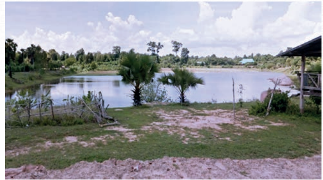
ขุดลอกหนองเม็ก เนื้อที่ ๓๔-๓-๕๙ ไร่ และเสริมคันคูพร้อมปรับเกวียนและบดอัดแน่น
