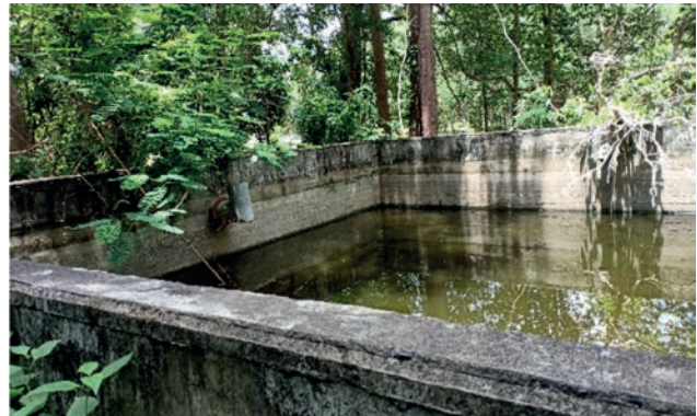
บ่อบักน้ำคอนกรีตเสริมเหล็ก
