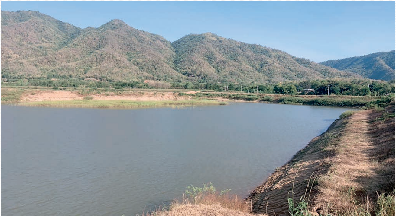
แก้มลิงห้วยใหญ่มีขนาดความจุ ๓๗๓,๐๐๐ ลูกบาศก์เมตร
