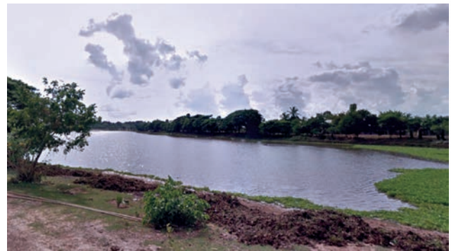
ขุดลอกหนองบัวดง เนื้อที่ ๑๙๘-๑-๒๖ ไร่ พร้อมก่อสร้างถนนลูกรัง
