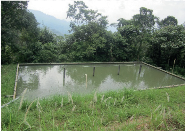
ถังเก็บน้ำ ขนาด ๑,๖๐๐ ลูกบาศก์เมตร
