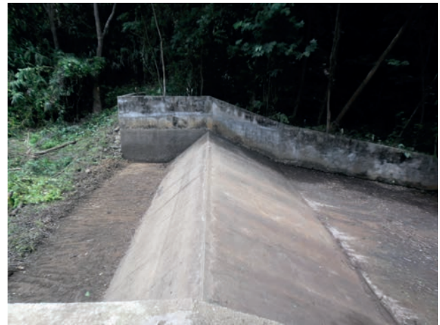
ยกระดับสันอาคารระบายน้ำล้น (Spillway) ขึ้นจากเดิมประมาณ ๑ เมตร
