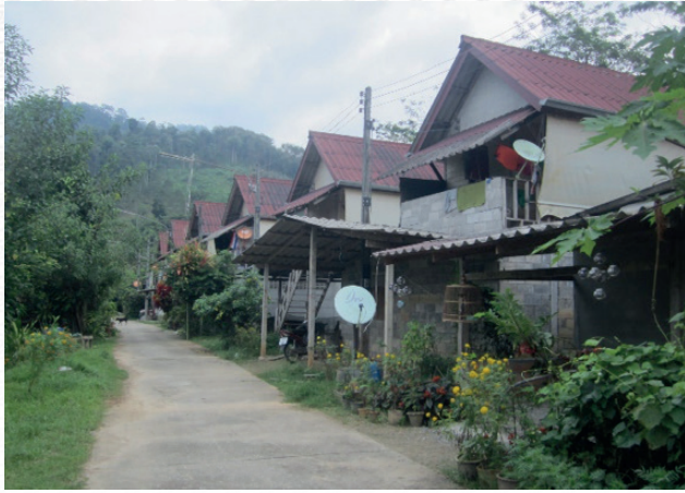
สภาพบ้านพักอาศัยของราษฎรในโครงการฯ จำนวน ๔๐ หลัง
