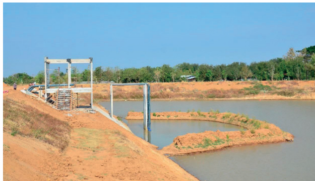
สถานีสูบน้ำด้วยไฟฟ้าบ้านห้วยแหวน
