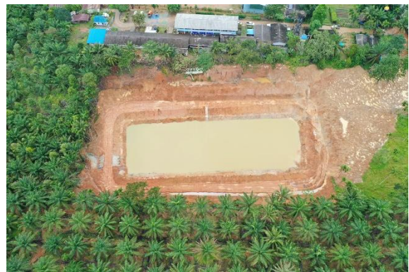
งานปรับปรุงสระเก็บน้ำให้สามารถเก็บกักน้ำได้ประมาณ ๑๐,๐๐๐ ลูกบาศก์เมตร พร้อมติดตั้งระบบท่อส่งน้ำและอาคารประกอบ ความยาว ๑๑๙ เมตร
