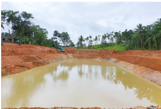
งานปรับปรุงสระเก็บน้ำให้สามารถเก็บกักน้ำได้ประมาณ ๑๐,๐๐๐ ลูกบาศก์เมตร พร้อมติดตั้งระบบท่อส่งน้ำและอาคารประกอบ ความยาว ๑๑๙ เมตร
