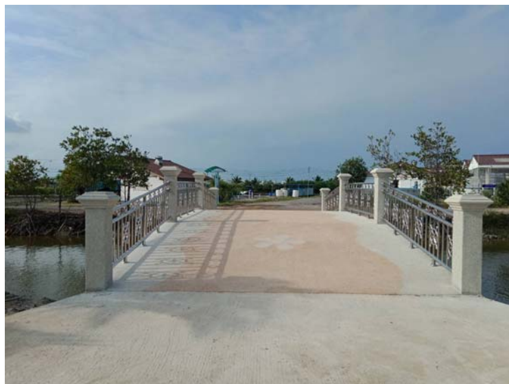
การก่อสร้างสะพานข้ามคลอง
