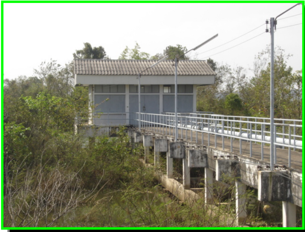
สถานีสูบน้ำดิบเหนือ ปตร.บ้านนาตุ๋
