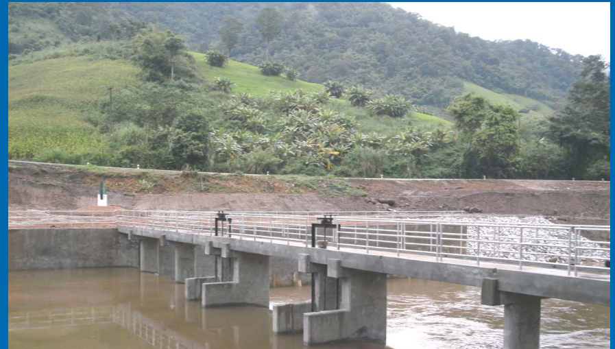
สภาพโดยทั่วไปของฝายบ้านรักชาติที่ก่อสร้างเสร็จแล้ว
