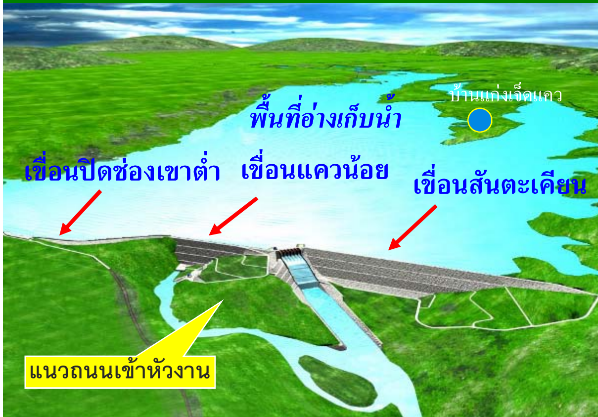
ชนิดของเขื่อนแควน้อย Concrete Faced Rockfill Dam ระดับสันเขื่อน +135.00 ม.รทก. ความยาวสันเขื่อน 681 เมตร ความสูงเขื่อน 75 เมตร
