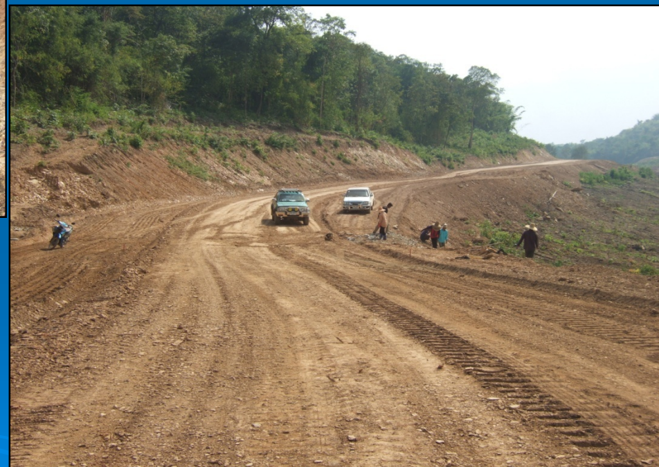
งานก่อสร้างถนนทดแทนน้ำท่วม
