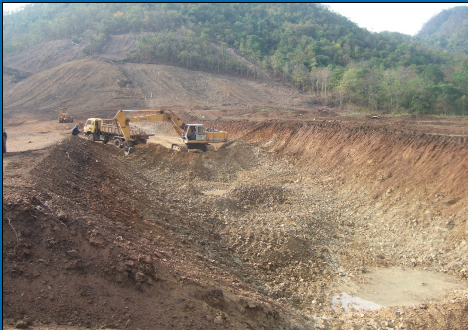
งานขุดเปิดร่องแกนเขื่อนดิน
