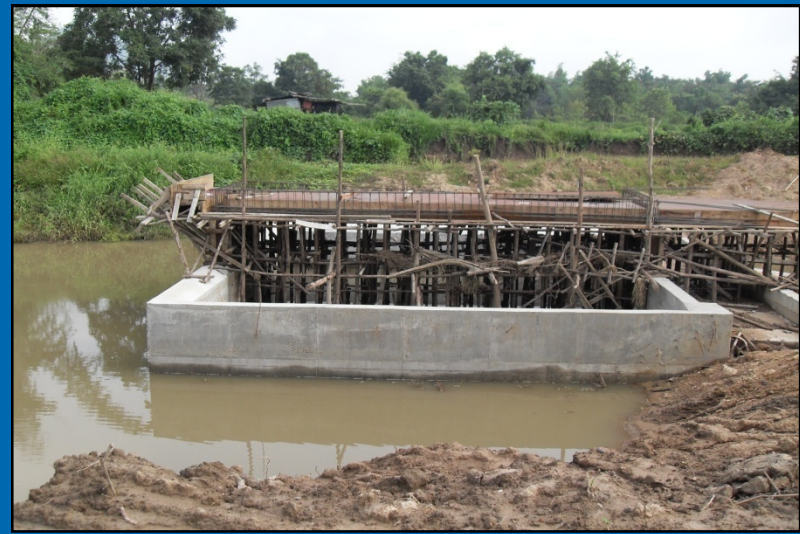
ระหว่างดำเนินการก่อสร้าง
