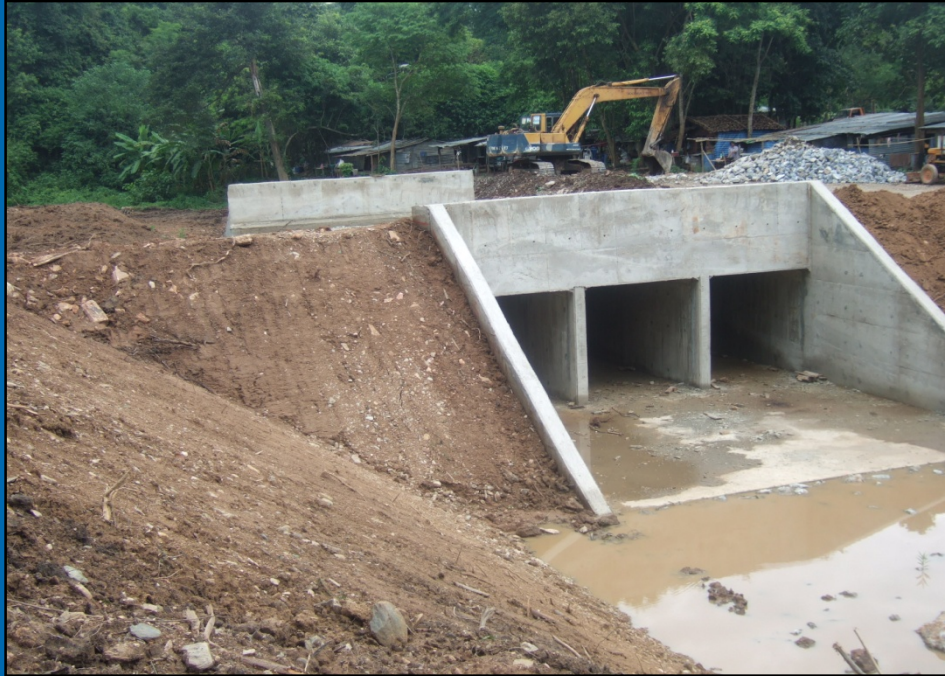
งานก่อสร้างท่อลอดถนน ทดแทนน้ำท่วม กม.1+643
