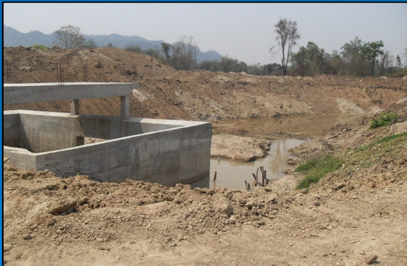
ระหว่างดำเนินการก่อสร้าง
