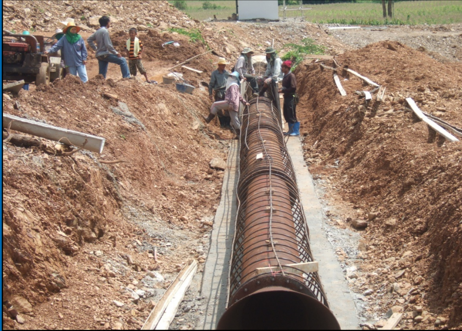
งานก่อสร้างท่อส่งน้ำ ลงลำน้ำเดิม (River Outlet)
