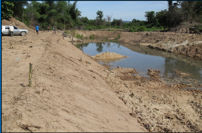
งานขุดบ่อก่อสร้าง
