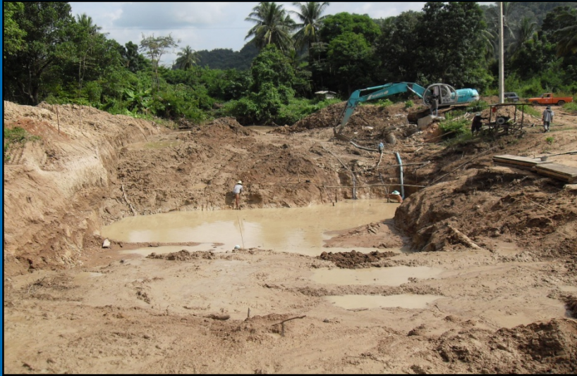
งานขุดบ่อก่อสร้าง
