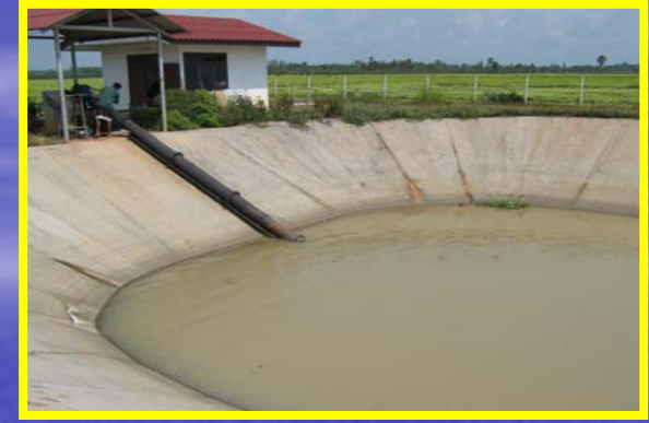
สถานีสูบน้ำด้วยไฟฟ้าบ้านนาลึก
