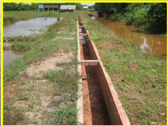
สถานีสูบน้ำด้วยไฟฟ้า ชายคลอง
