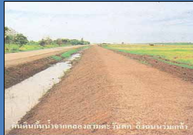
ถนนยกระดับใหม่เป็นคันกันน้ำจากซอยแอนเนกซ์ ถึงคลองพระยาสุเรนทร์
