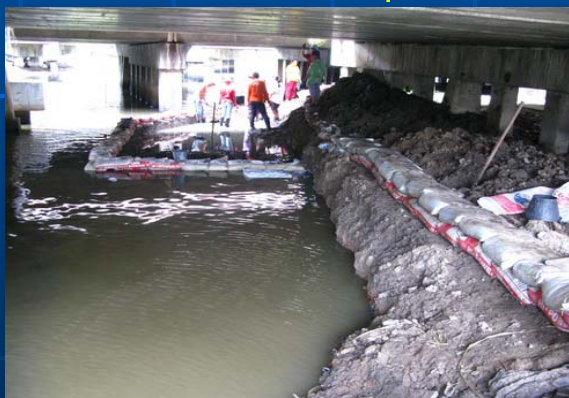
การขุดลอกตะกอนดินใต้สะพานถนนบางนาตราด โดยใช้แรงงานคนดำเนินการ
