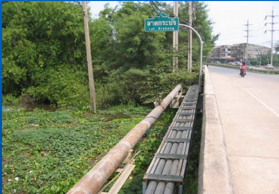
สภาพอุปสรรควัชพืชและตะกอนดินสะสมบริเวณต่อม่อสะพาน
