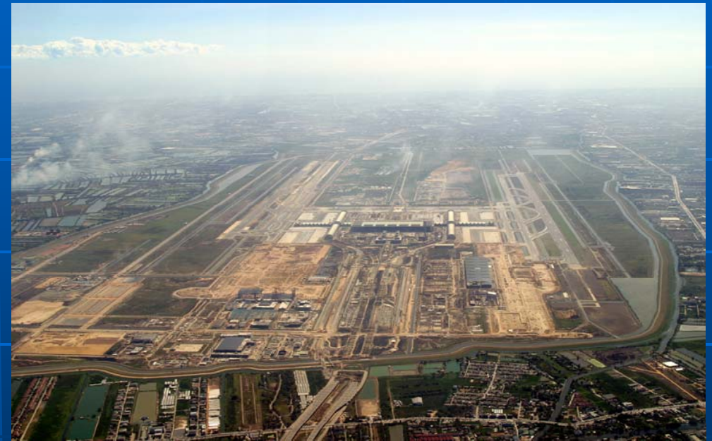
การก่อสร้างท่าอากาศยานสุวรรณภูมิ
