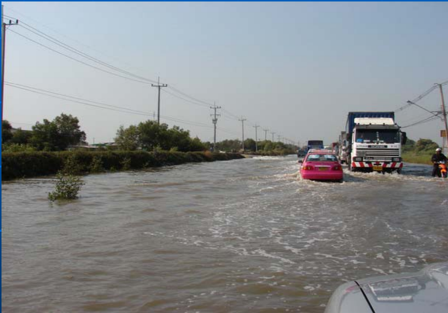
สภาพน้ำทะเลดันแนวคันบริเวณถนนสุขุมวิท
