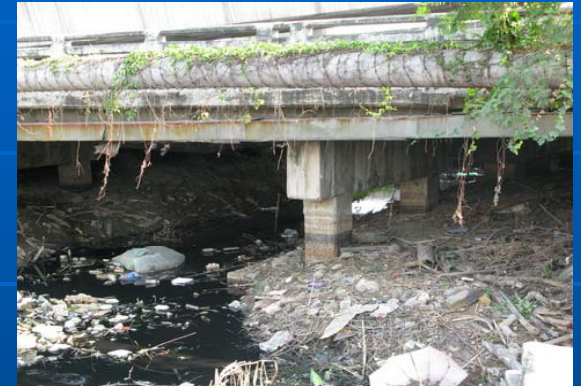
สภาพอุปสรรควัชพืชและตะกอนดินสะสมบริเวณต่อม่อสะพาน
