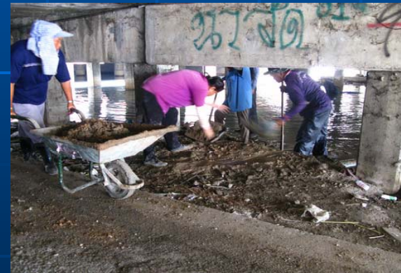
การขุดลอกตะกอนดินใต้สะพานถนนบางนาตราด โดยใช้แรงงานคนดำเนินการ
