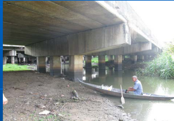
สภาพอุปสรรควัชพืชและตะกอนดินสะสมบริเวณต่อม่อสะพาน
