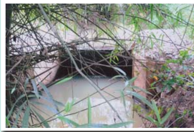
การก่อสร้างฝายต้นน้ำแบบถาวร
