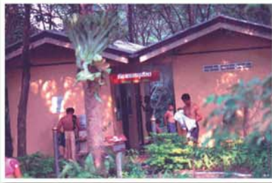
❖ อาคารอบสมุนไพรหลังเดิม
