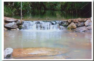
ฝายต้นน้ำแบบผสมผสาน เพื่อชะลอการไหลของน้ำ
