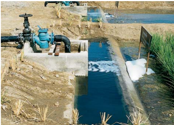
ภาพที่ 9 ลักษณะการให้น้ำหรือการระบายน้ำเสียเข้าแปลงบำบัดน้ำเสียด้วยระบบพืกรองน้ำเสีย
