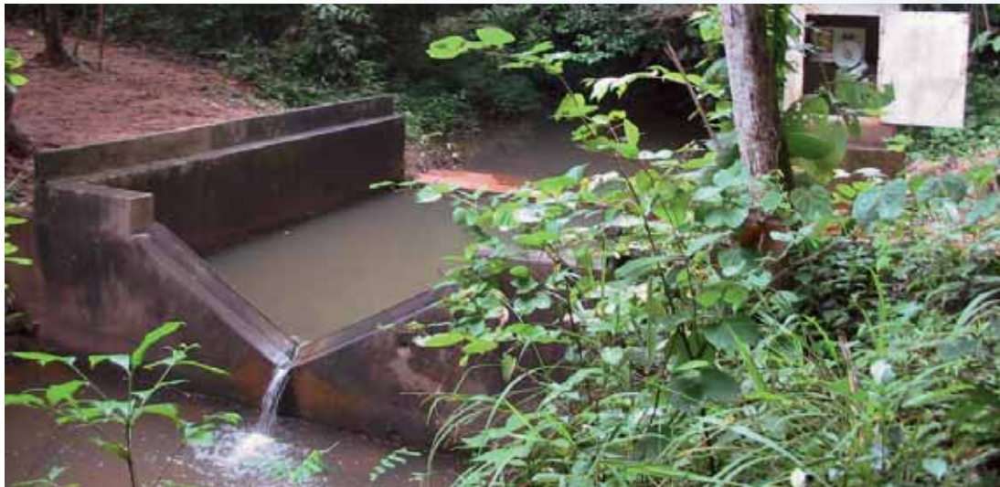
ภาพเขื่อนวัดน้ำ แบบ ๑๒๐° V-Notch Weir
