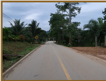
ก่อสร้างทางหลวงชนบทชั้นที่ ๔ ผิวจรรยาลาดยางแบบผิวเรียบ
