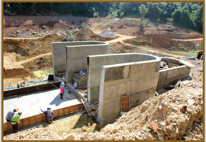
การก่อสร้างอ่างเก็บน้ำ หุบตาหวัด
