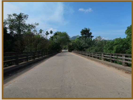
ก่อสร้างสะพานคอนกรีตอัดแรงข้ามคลองยัน
