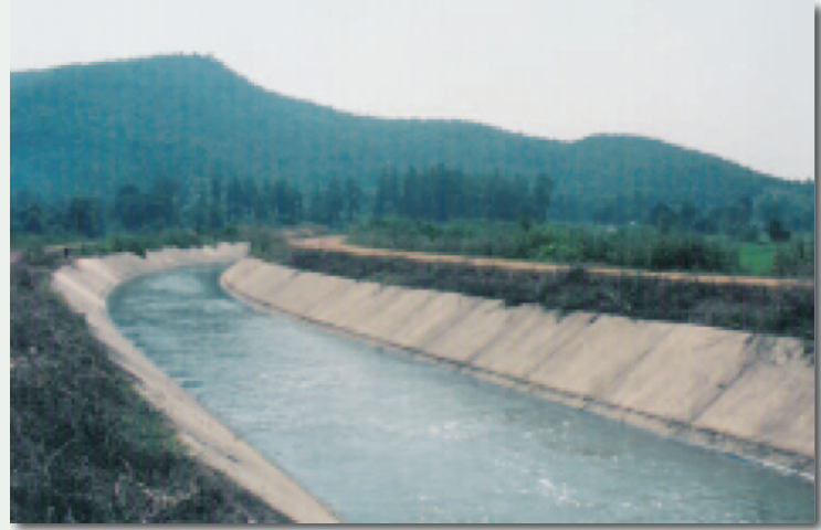
คลองส่งน้ำลาดด้วยคอนกรีต
