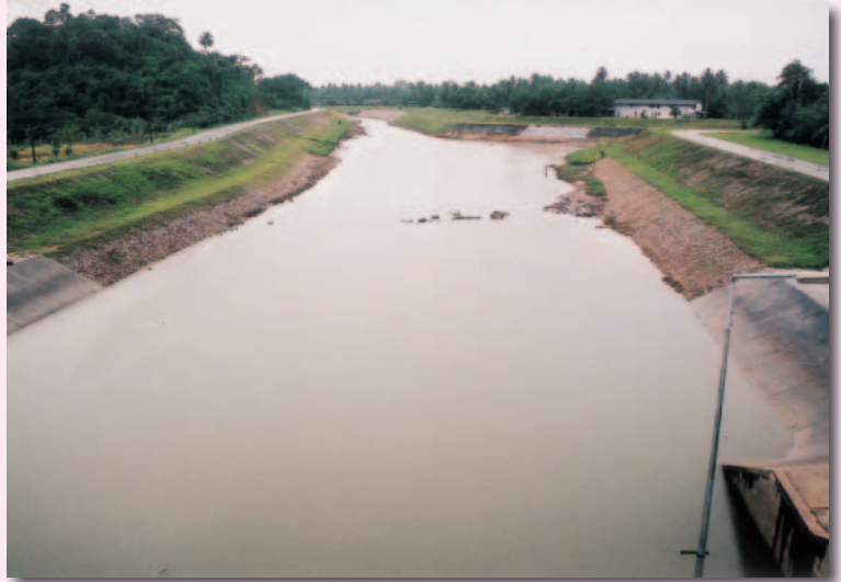
คลองระบายน้ำรอบโครงการพัฒนาพื้นที่หนองใหญ่
