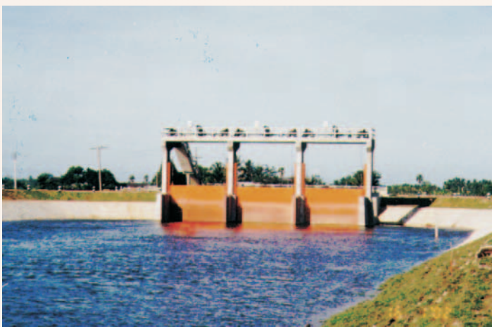
อาคารประตูระบายน้ำกลางคลองมุโนะ
