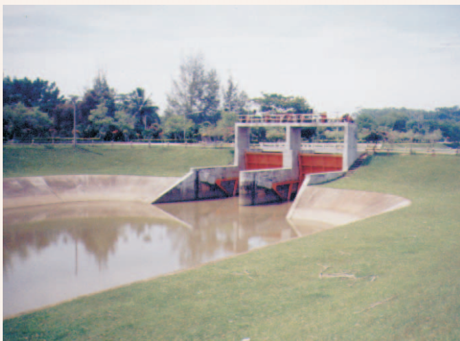
อาคารประตุน้ำปลายคลองมูโนะ
