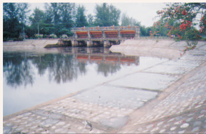
อาคารประตูระบายน้ำปลายคลองมุโนะ
