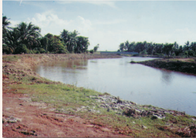
คลองระบายน้ำโต๊ะแดง
