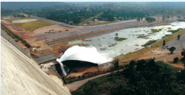
อาคารระบายน้ำล้นด้านท้ายเขื่อนลงลำน้ำเดิม และระบายน้ำลงพื้นที่โครงการ ส่งน้ำ และบำรุงรักษานครนายก ๑๖๕,๐๐๐ ไร่
