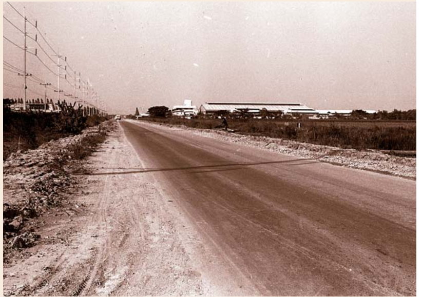
คันกั้นน้ำที่ก่อสร้างขึ้นใหม่ รวมระยะทางประมาณ ๑๒ กิโลเมตร
