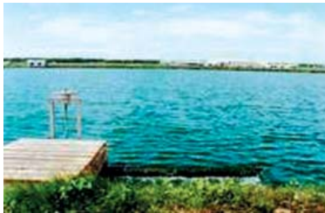
ภาพที่ 6 ลักษณะอาคารระบายน้ำล้น
