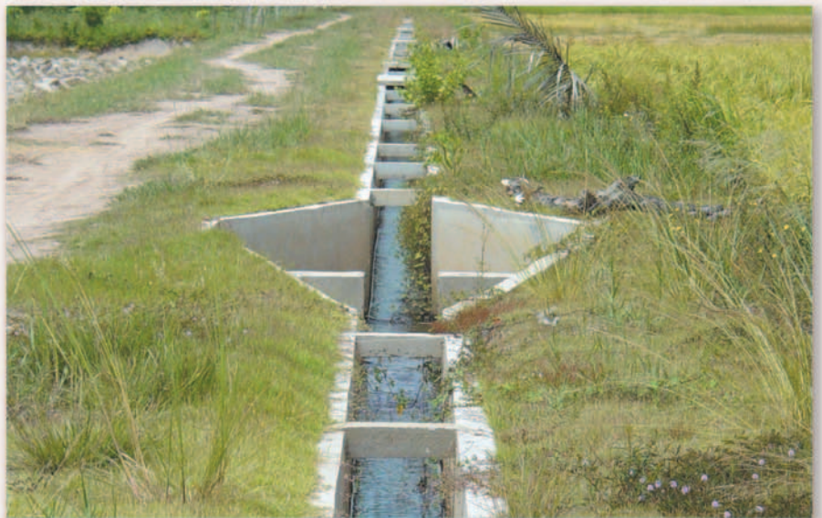
▲ ร้างส่งน้ำที่จะส่งน้ำเข้าพื้นที่การเกษตรของราษฎร
