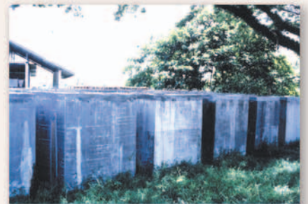
▲ กล่องคอนกรีตเสริมเหล็ก สำหรับใช้เป็นที่กักของชั่วคราวคลองบางแก้วและคลองปากพะเนียด ขนาด ๒.๐๐ x ๒.๐๐ x ๒.๒๐ เมตร จำนวน ๒๒ กล่อง วิธีการโดยนำกล่องดังกล่าวไปวางให้ชิดกับในคลองบางแก้วและคลองปากพะเนียดช่วงฤดูแล้ง เพื่อป้องกันน้ำเค็มรุกเข้าพื้นที่
