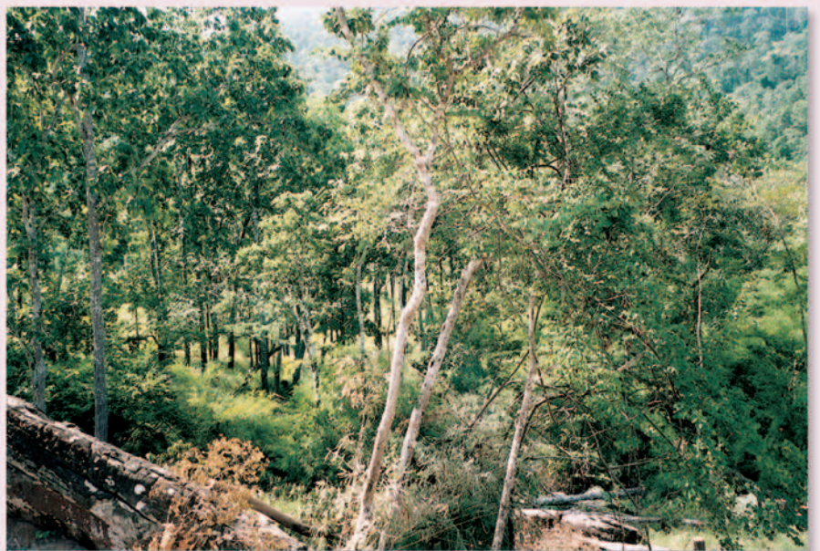
▲ สภาพพื้นที่ก่อนดำเนินการก่อสร้างอ่างเก็บน้ำลำพันชาดน้อย
