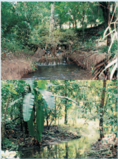
▲ การทำฝายชะลอความชุ่มชื้น (check dam) และเหมืองไล่ไถ่ ภายใน ศูนย์ศึกษาการพัฒนาห้วยฮ่องไคร้ฯ
