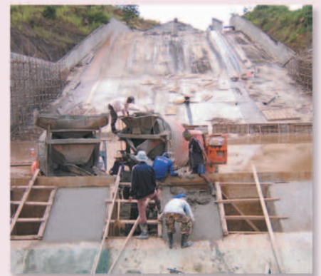
▲ การก่อสร้างอ่างเก็บน้ำลำพันชาดน้อย
