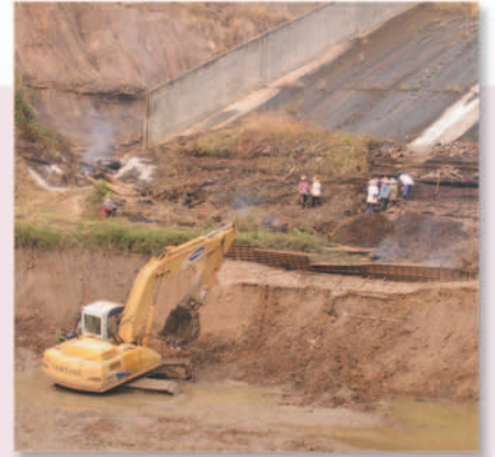
▲ การก่อสร้างอ่างเก็บน้ำลำพันชาตน้อย
