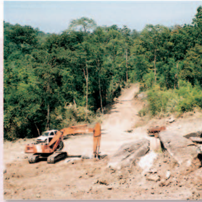
▲ การก่อสร้างถนนในพื้นที่โครงการฯ
