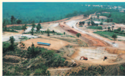
| บริเวณพื้นที่ก่อสร้างเขื่อนแก่งเสือเต้น
