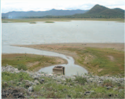
สภาพอ่างเก็บน้ำบ้านทุ่งขาม
