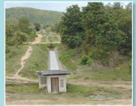
| คลองส่งน้ำของอ่างเก็บน้ำบ้านทุ่งขาม
