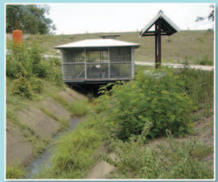
ประตูส่งน้ำเข้าคลองส่งน้ำห้วยตะแบก- อ่างเก็บน้ำเขากระปุก
