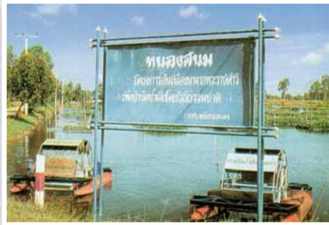
เข้าในบ่อเติมอากาศ ซึ่งจะมีการเติมอากาศด้วยเครื่องเติมอากาศตลอดเวลา เพื่อให้แบคทีเรียทำการย่อยสลายสารอินทรีย์ในน้ำเสีย โดยปฏิกิริยาแบบการให้ออกซิเจนอย่างต่อเนื่อง จากนั้นจะไหลไปยังบ่อกึ่งไร้อากาศเพื่อบำบัดสารอินทรีย์ที่หลงเหลือในบ่อน้ำ เมื่อน้ำใสแล้วจะระบายทิ้งลงคลองลาดพร้าวตามเดิม ผลปรากฏว่าคุณภาพน้ำในคลองดีขึ้น
