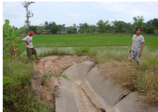
การส่งน้ำผ่านระบบคลองตาดคอนกรีตที่ชำรุดทำให้เกษตรกรใช้ประโยชน์จากน้ำได้ไม่เต็มประสิทธิภาพ
