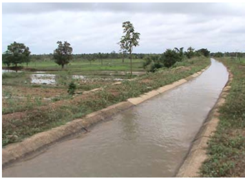
การทรุดตัวของดินส่งผลให้ระบบคลองตาดคอนกรีตชำรุด ไม่สามารถส่งน้ำได้
