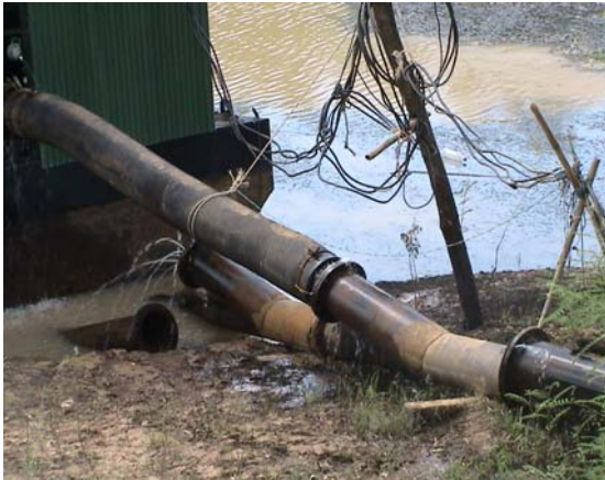
ท่อส่งน้ำที่ชำรุด เกิดน้ำรั่วซึม ส่งผลให้แรงดันน้ำลดลง
