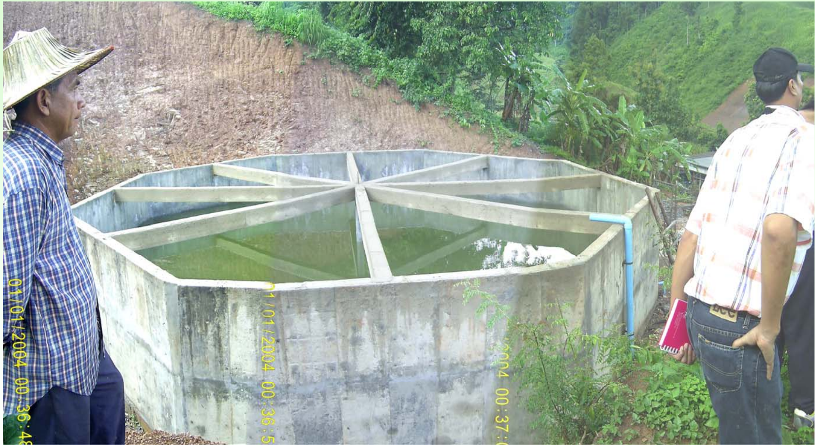
กิจกรรมที่ 3- ก่อสร้างบ่อพักน้ำคอนกรีตเสริมเหล็กขนาดความจุ 270 ลบ.ม. บริเวณโรงเรียนบ้านท่าวะ
