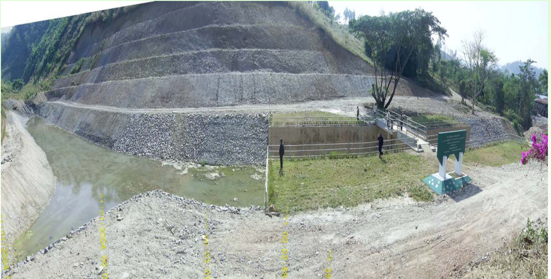
กิจกรรมที่ 1 – ก่อสร้างฝายคอนกรีตล้นปนหินใหญ่ขนาดยาว 10 ม. สูง 3 ม. บริเวณหลังโรงเรียนบ้านท่าวะ
