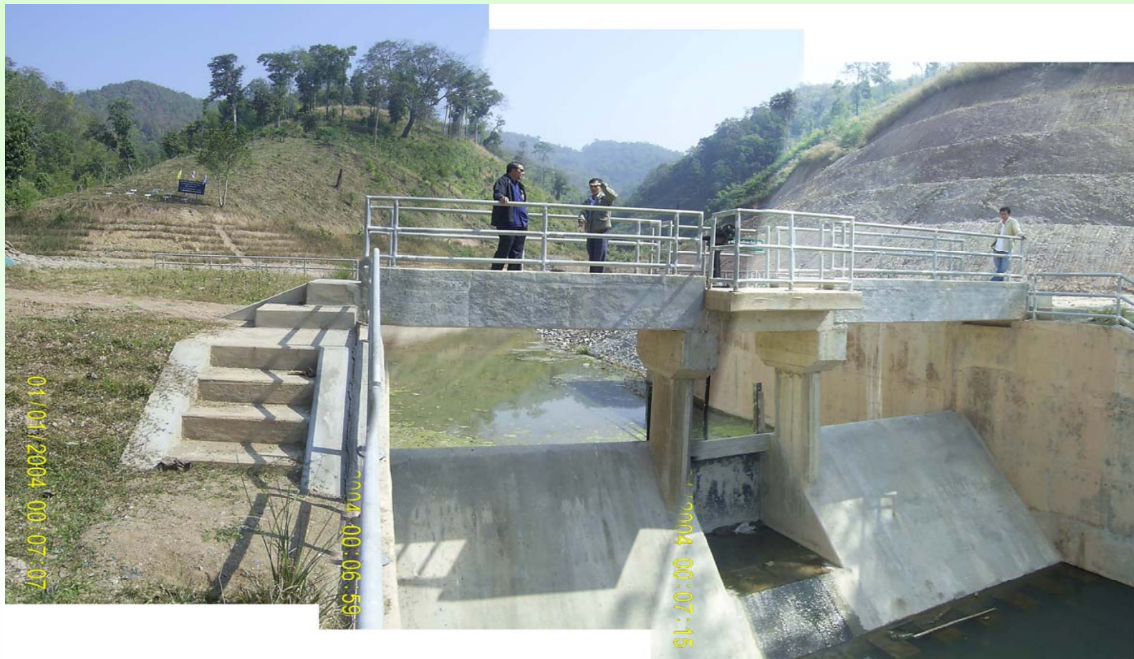
กิจกรรมที่ 1 - ก่อสร้างฝายคอนกรีตล้นปนหินใหญ่ขนาดยาว 10 ม. สูง 3 ม. บริเวณหลังโรงเรียนบ้านท่าวะ
