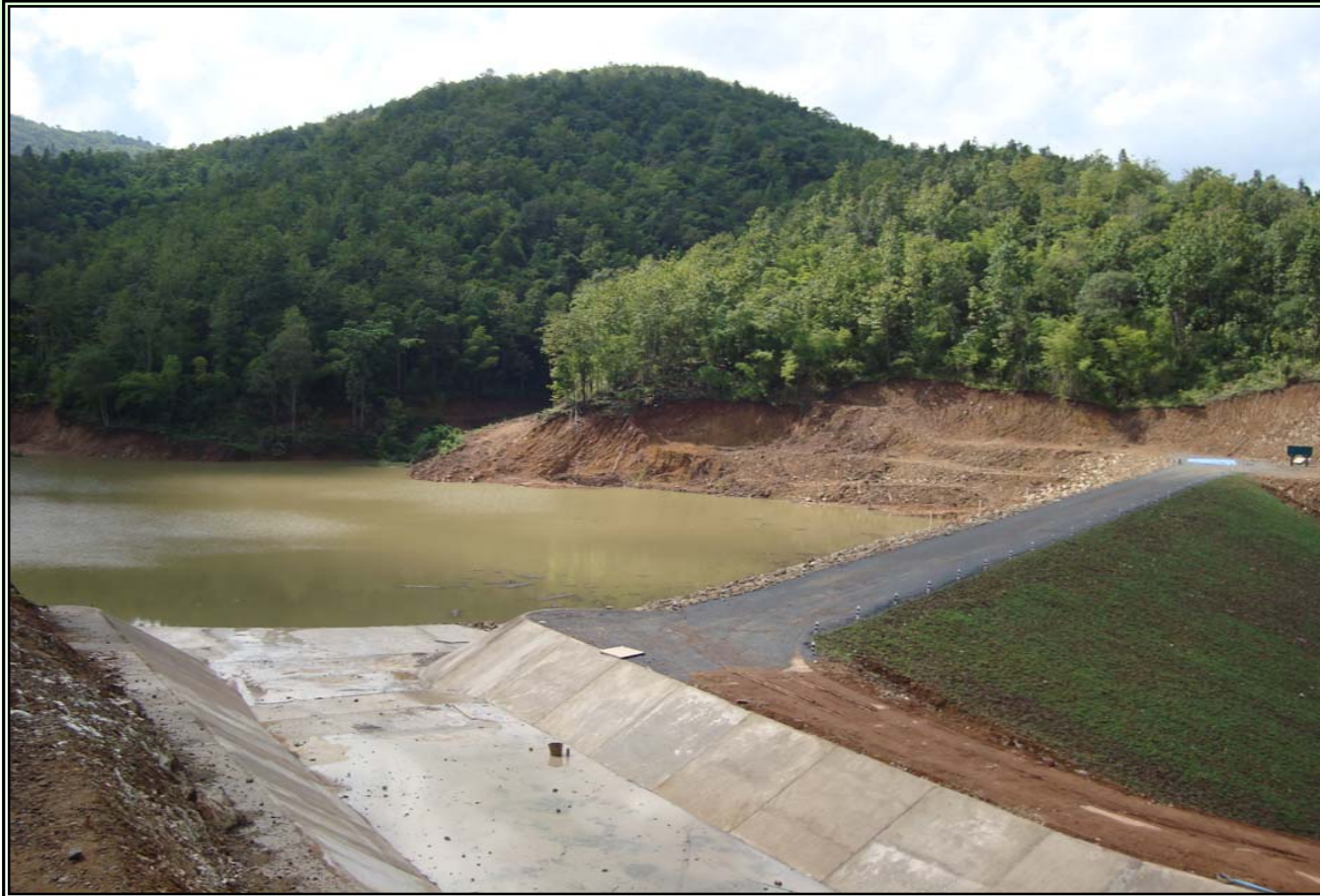
กิจกรรม ก่อสร้างทำนบดินและอาคารระบายน้ำล้น
