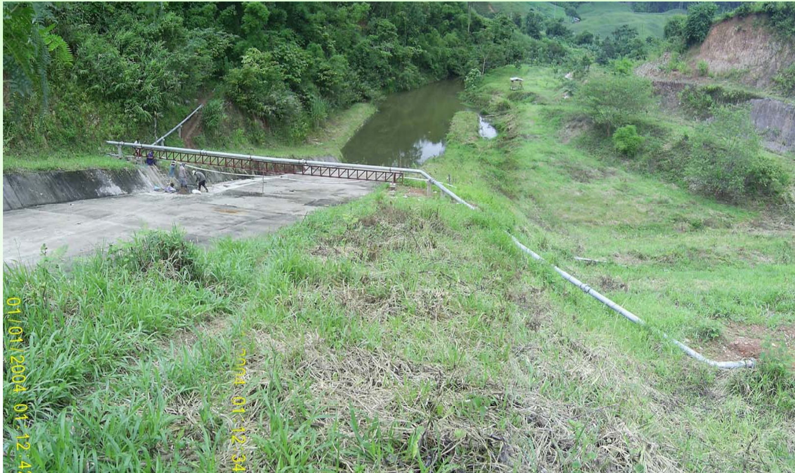
กิจกรรมที่ 2 - ก่อสร้างระบบท่อส่งน้ำ ยาว 2,221 ม. จากฝายต้นน้ำถึง บ่อบักน้ำในโรงเรียนบ้านท่าวะ
