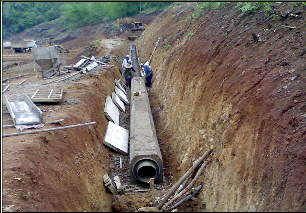
กิจกรรม ก่อสร้างท่อส่งน้ำฝ่งซ้าย
