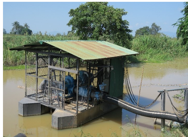
สถานีสูบน้ำด้วยไฟฟ้าบ้านโนนลานฯ (แพสูบน้ำ อัตราการสูบน้ำ 0.20 ลูกบาศก์เมตร/วินาที)
