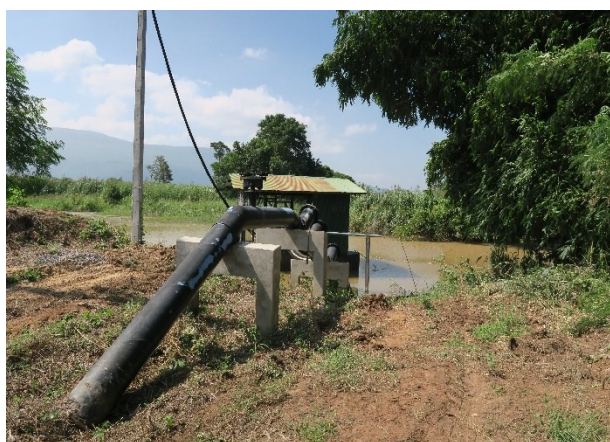
ท่อสูบน้ำริมตลิ่งท่อเหล็กเหนียว ความยาว 20 เมตร
