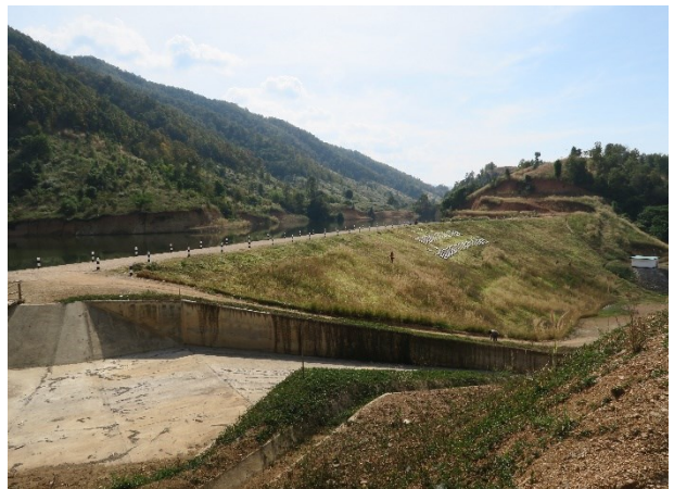
อาคารระบายน้ำล้นชนิดรางเท
