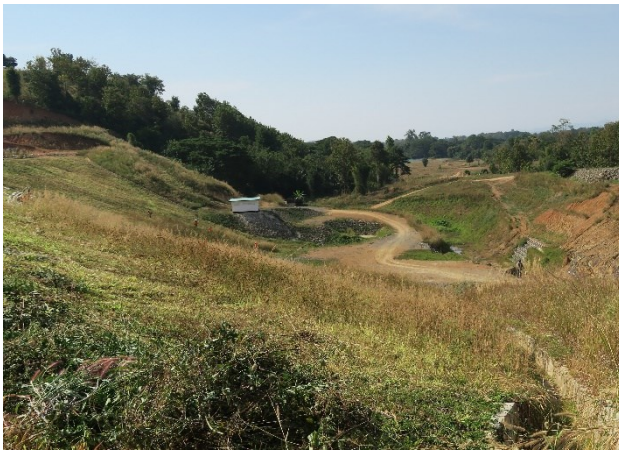
อาคารประกอบท่อส่งน้ำชนิด Concrete Steel Liner
