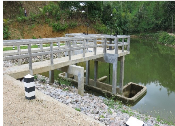
อาคารอัดน้ำ 2 ช่องสี่เหลี่ยม ขนาด 2.50x2.50 เมตร ยาว 24.00 เมตร อาคารรับน้ำ สูง 5.20 เมตร ทำนบดินสูง 7.70 เมตร
