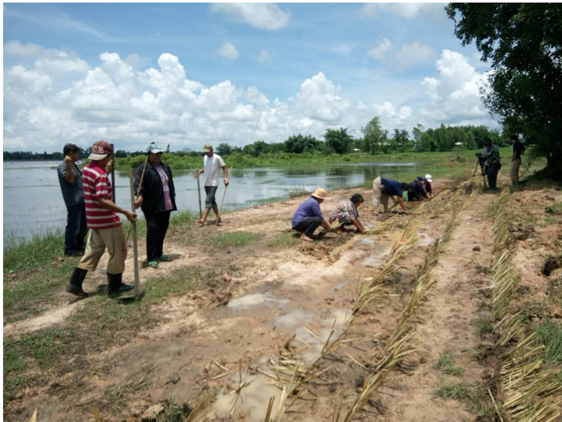
ภาพการปลูกหญ้าแฝกเพื่อป้องกันการพังทลายของดิน และป้องกันตะกอนทรายตกจมลงในอ่างเก็บน้ำ เมื่อวันที่ 10 สิงหาคม 2560
