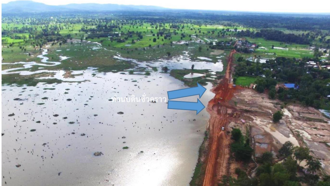
บริเวณที่ทำการซ่อมแซมทำนบดินชั่วคราว แล้วเสร็จเมื่อวันที่ 12 สิงหาคม 2560
