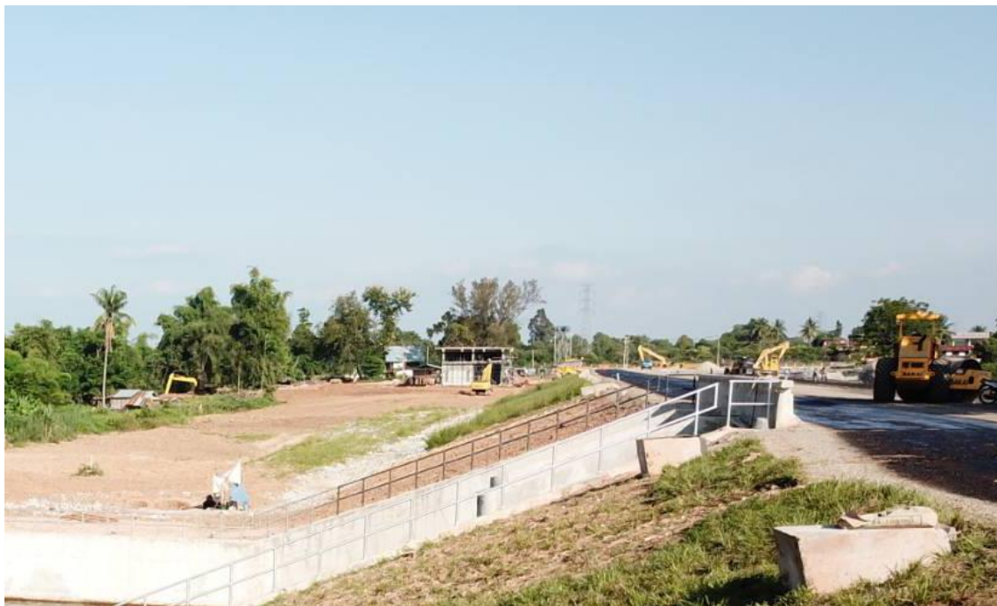
ภาพกิจกรรมอาคารท่อดส่งน้ำฝ่งขวาและอาคารท่อดระบายน้ำลงลำน้ำเดิมเมื่อดำเนินการแล้วเสร็จ
