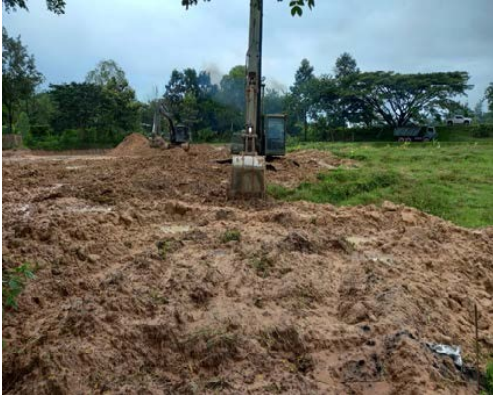
บริเวณก่อสร้างโรงเลี้ยงพ่อแม่พันธุ์ไก่
