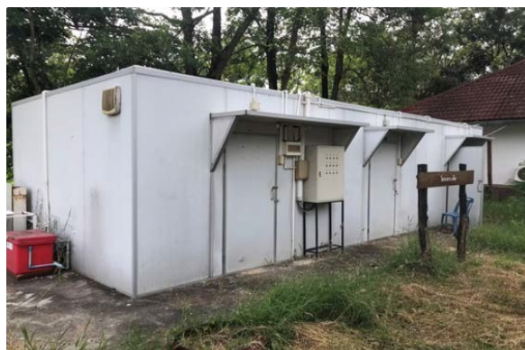
โรงเก็บเมล็ดพันธุ์ก่อนดำเนินการปรับปรุง
