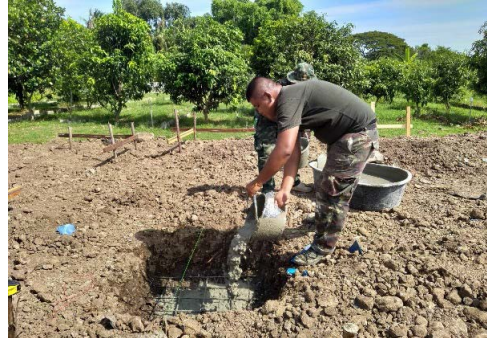
บริเวณพื้นที่ก่อสร้างโรงเพาะพันธุ์สัตว์น้ำ จังหวัดบุรีรัมย์
