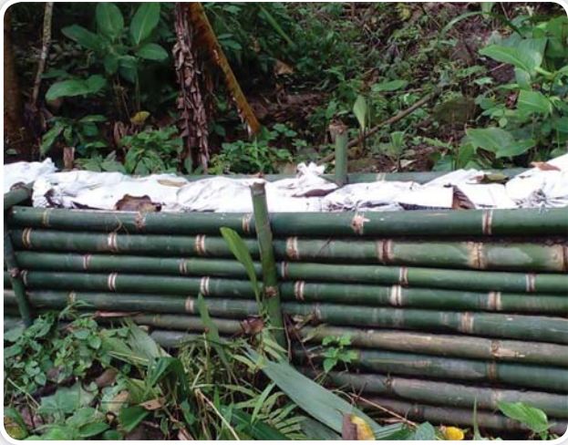
ก่อสร้างฝายต้นน้ำแบบคอกหมู จำนวน 22 แห่ง
