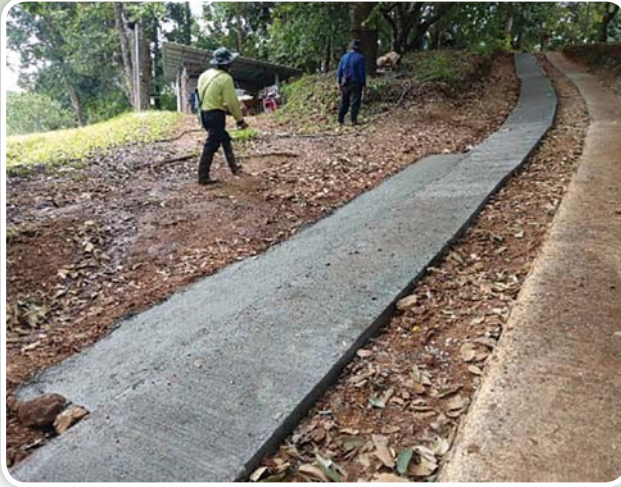
ก่อสร้างถนนคอนกรีต (อินเดีย) ระยะทาง 250 เมตร
