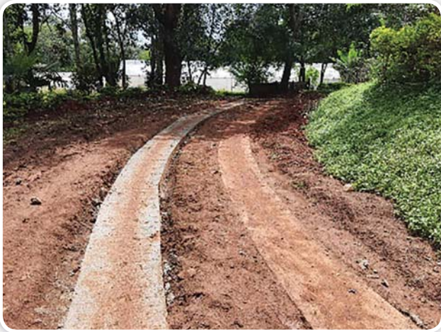
ก่อสร้างถนนคอนกรีตเสริมเหล็ก แบบสองร่องล้อ ระยะทาง 500 เมตร
