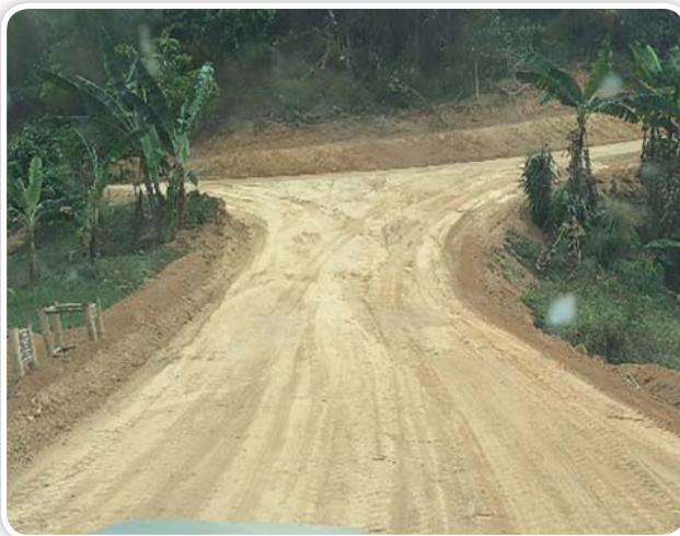
ก่อสร้างถนนป่าไม้ลำลอง ระยะทาง 10 กิโลเมตร
