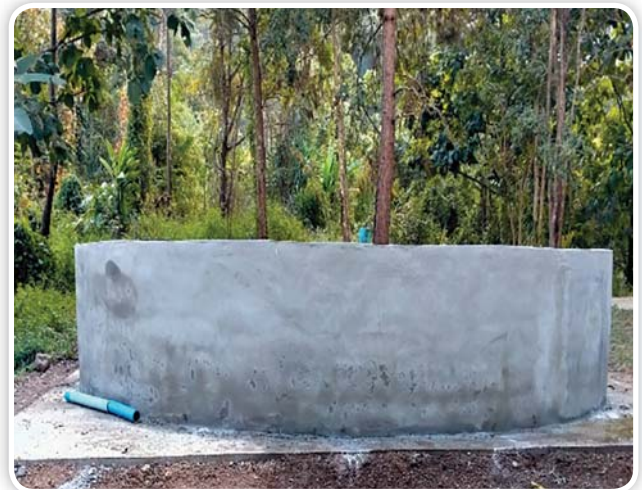
ก่อสร้างบ่อพักน้ำเพื่อการเกษตร (บ่อพวง) จำนวน 5 บ่อ
