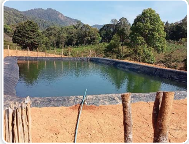
ก่อสร้างบ่อพักน้ำเพื่อการเกษตร จำนวน 2 บ่อ
