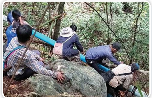
ซ่อมแซมระบบกระจายน้ำ ในพื้นที่ทำกินที่จัดสรรให้ราษฎร
