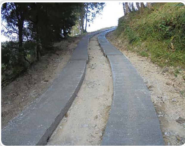
ก่อสร้างถนนคอนกรีตเสริมเหล็ก แบบสองร่องล้อ ระยะทาง 500 เมตร
