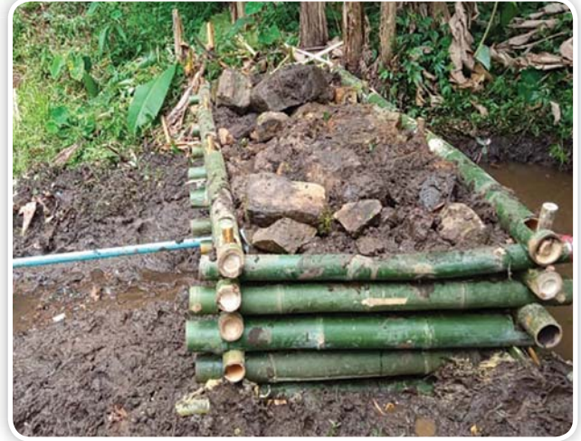
ก่อสร้างฝายต้นน้ำแบบคอกหมู จำนวน 15 ฝาย
