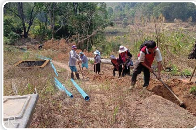
ซ่อมแซมระบบกระจายน้ำ ในพื้นที่ทำกินที่จัดสรรให้ราษฎร
