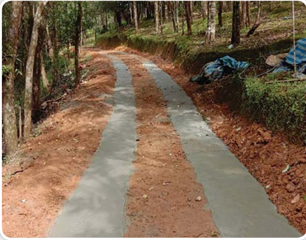
ก่อสร้างถนนคอนกรีตเสริมเหล็กสองร่องล้อ ระยะทาง 650 เมตร
