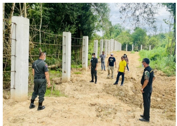
ก่อสร้างรั้วป้องกันช้าง
