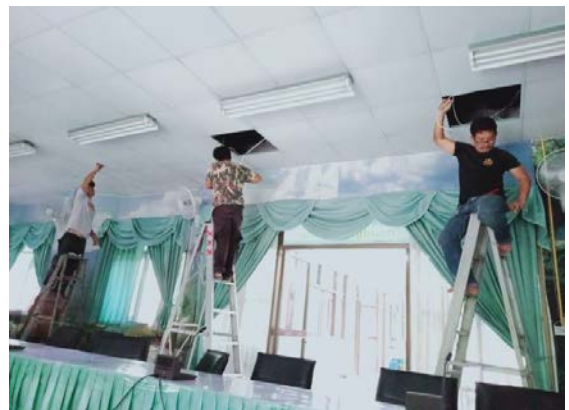
ปรับปรุงระบบไฟฟ้าภายในและภายนอก อาคารศูนย์ปฏิบัติการป่าไม้และสัตว์ป่า
