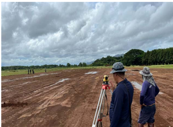
ขณะดำเนินการปรับปรุงไหล่ทางวิ่ง
