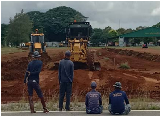
ขณะดำเนินการปรับปรุงไหล่ทางวิ่ง
