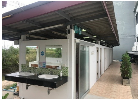
ก่อสร้างห้องสุขาชาย
