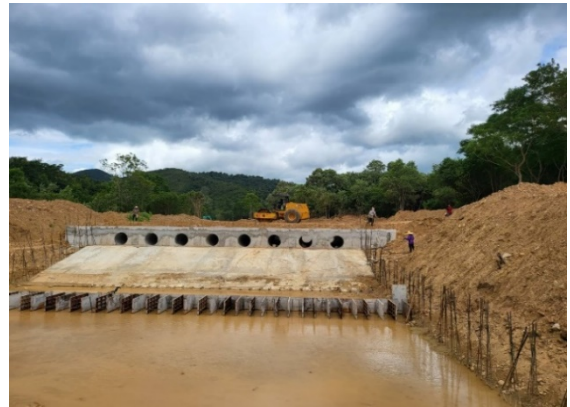
ระหว่างดำเนินการก่อสร้างฝายชะลอน้ำพร้อมทางข้ามด้านบนทำนบ
