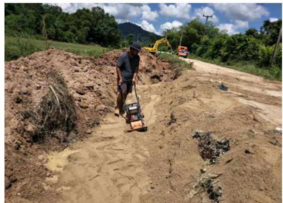
ขณะดำเนินการวางระบบท่อส่งน้ำ
