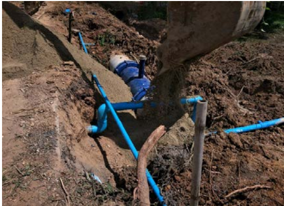
บริเวณจุดเชื่อมต่อระหว่างระบบท่อส่งน้ำของโครงการกับระบบท่อส่งน้ำเดิมของอ่างเก็บน้ำคลองสี่เสียด
