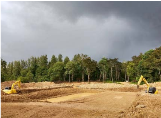
ระหว่างดำเนินการก่อสร้างฝายชะลอน้ำพร้อมทางข้ามด้านบนทำนบ
