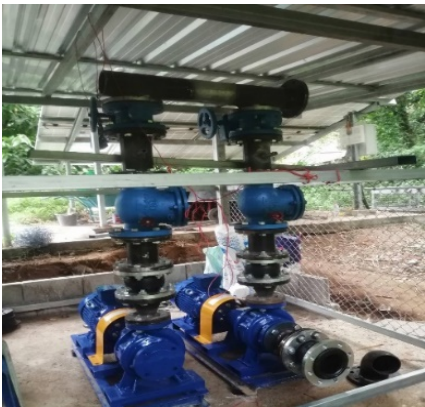
ดำเนินการก่อสร้างโรงสูบน้ำ พร้อมติดตั้งเครื่องสูบน้ำพลังงานแสงอาทิตย์
