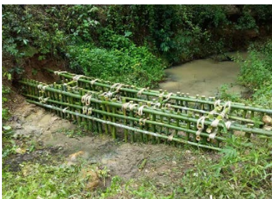
ก่อสร้างฝายต้นน้ำแบบคอกหมู
