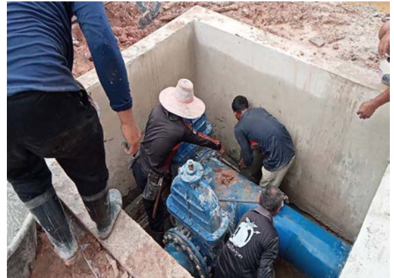
บริเวณจุดเชื่อมต่อระหว่างระบบท่อส่งน้ำของโครงการกับระบบท่อส่งน้ำเดิมของอ่างเก็บน้ำคลองสี่เสียด
