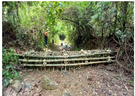
ก่อสร้างฝายต้นน้ำแบบคอกหมู
