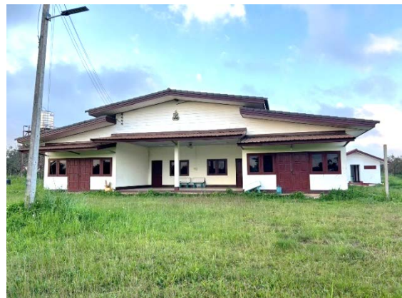
งานซ่อมแซมหอพัก พร้อมตู้ล็อกเกอร์เก็บของ
