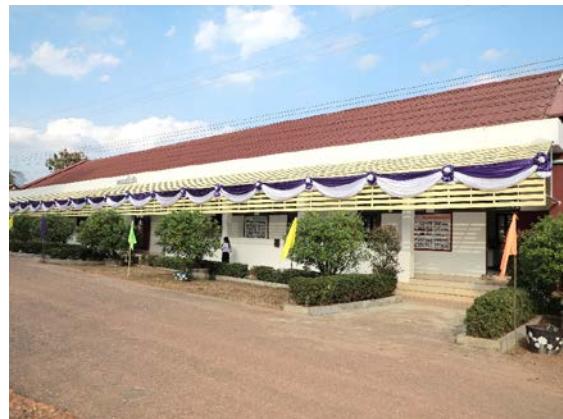
ปรับปรุงซ่อมแซมอาคารปฏิบัติการวิทยาศาสตร์
