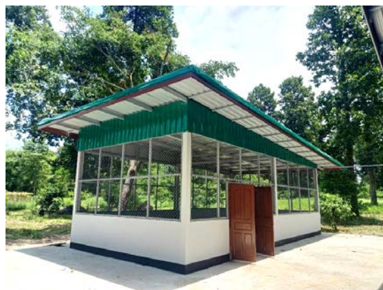
งานขยายโรงเก็บปุ๋ย
