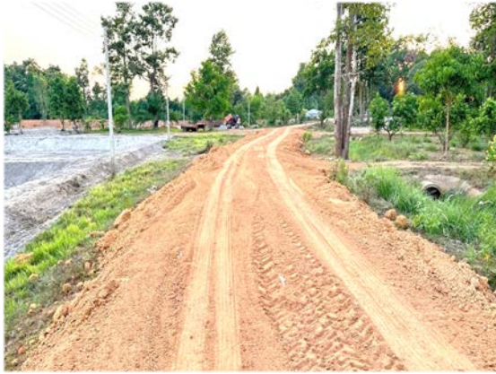
งานซ่อมแซมถนน
