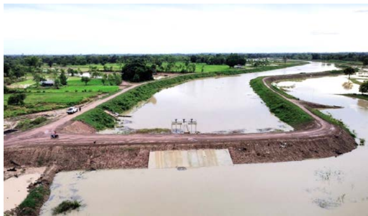
กิจกรรมขุดลอกแก้มลิงกุดนาแซงพร้อมอาคารประกอบ
