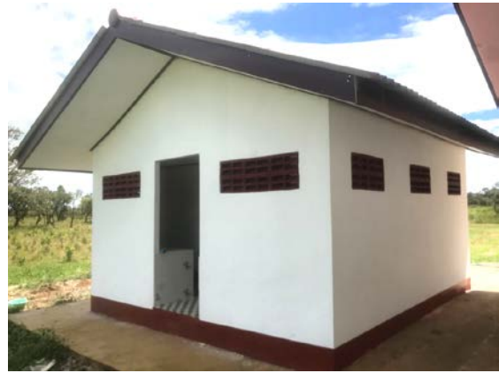
งานซ่อมแซมอาคารที่ทำการ
