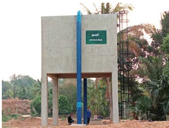
บ่อพักน้ำ
