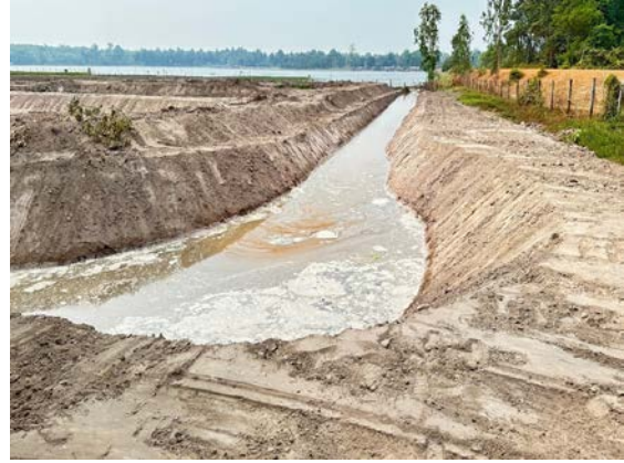
งานขุดลอกและจัดทำร่องน้ำ
