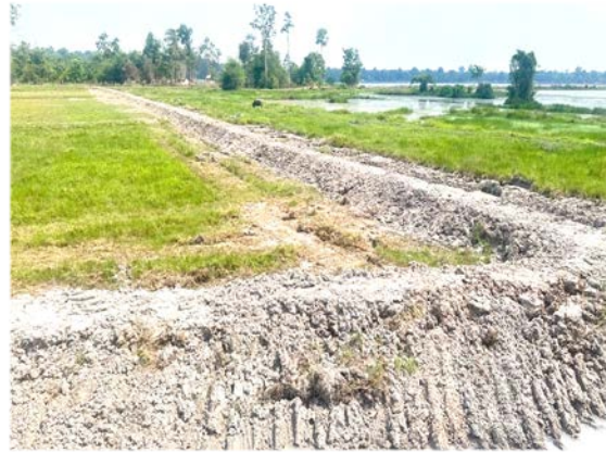
งานก่อสร้างคันกั้นน้ำและซ่อมแซมร่องน้ำ
