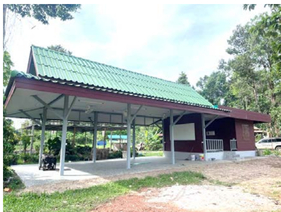
งานก่อสร้างอาคารฝึกอบรม
