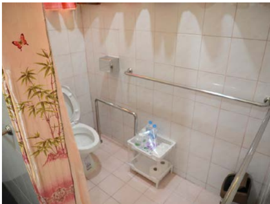
ปรับปรุงห้องน้ำภายในอาคารสโมสร
