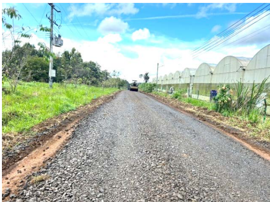
งานซ่อมแซมถนน (ถนนหินคลุก)
