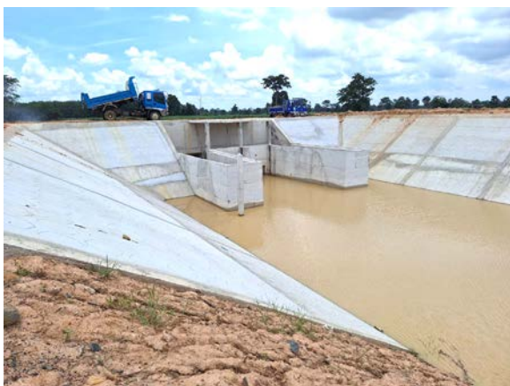
ฝายห้วยจงกอพร้อมอาคารประกอบ
