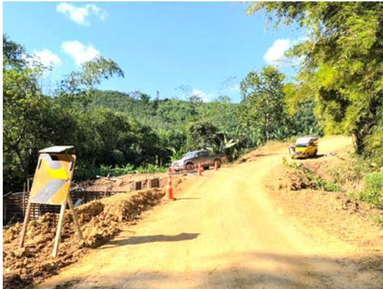
กิจกรรมก่อสร้างถนน
