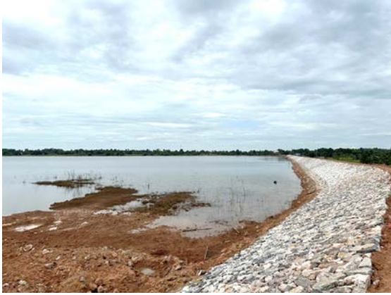
พื้นที่ขุดลอกอ่างเก็บน้ำห้วยไร่
