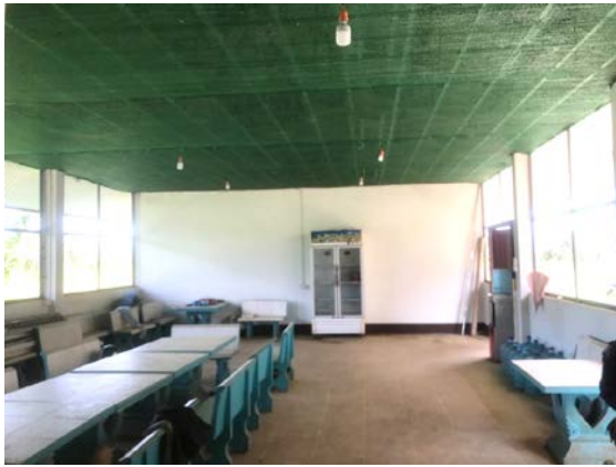
งานซ่อมแซมโรงอาหาร
