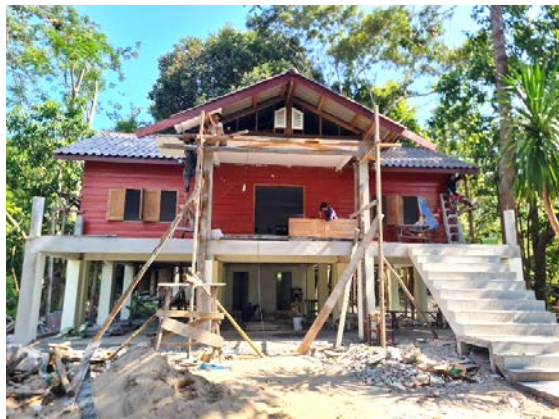
งานก่อสร้างอาคารป่าไม้
