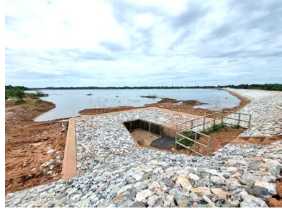
งานปรับปรุงอาคารระบายน้ำล้น
