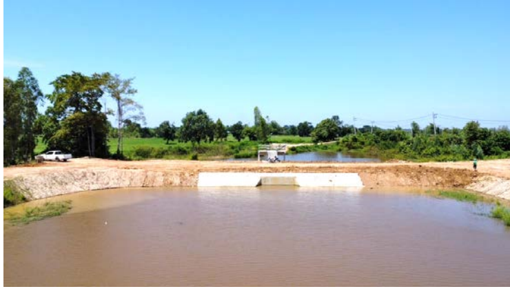
กิจกรรมขุดลอกแก้มลิงหนองเบนพร้อมอาคารประกอบ
