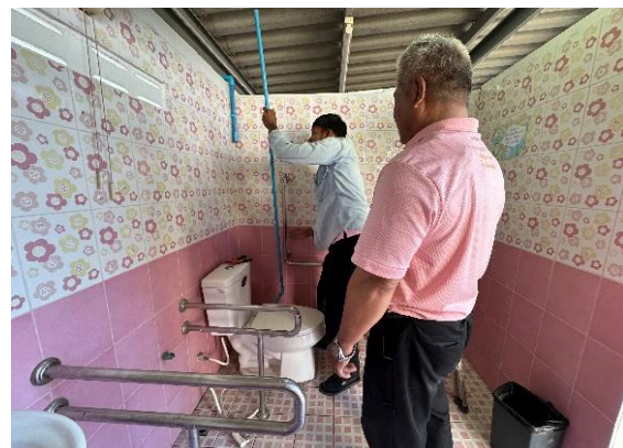
ซ่อมอาคารห้องน้ำรวม (หญิง)
