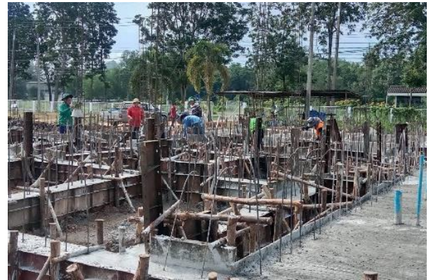
ก่อสร้างอาคารกายภาพบำบัดของ โรงพยาบาลพยาบาลสถานพระบารมี คาดว่าจะแล้วเสร็จเดือนเมษายน ๒๕๖๘
