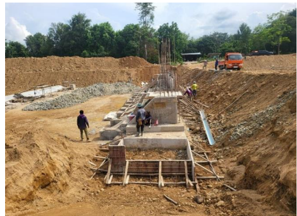
ระหว่างการดำเนินงานก่อสร้างฝายทดน้ำคอนกรีตเสริมเหล็ก
