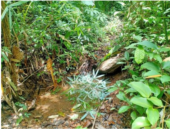
พื้นที่ดำเนินงานวางท่อส่งน้ำริมตลิ่ง
