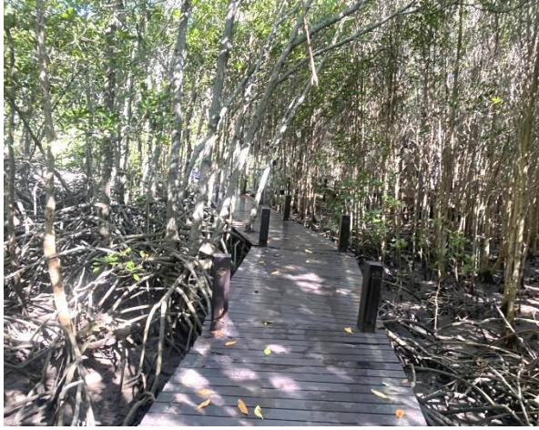
ระหว่างดำเนินการก่อสร้างราวสะพาน
