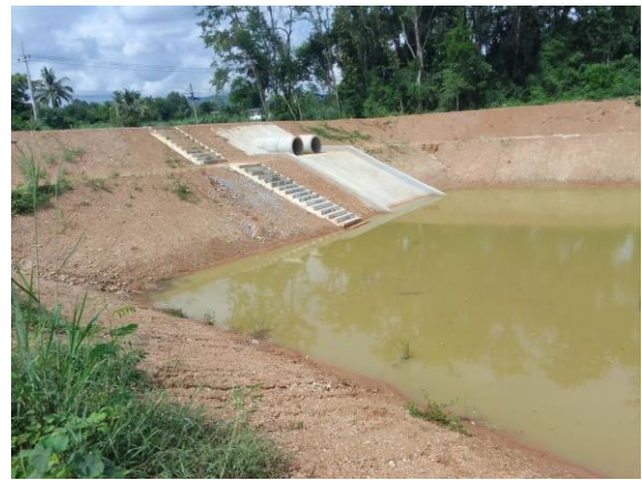
อาคารรับน้ำจากน้ำหลากในช่วงฤดูฝน
