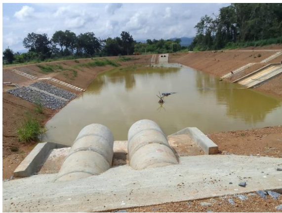
อาคารระบายน้ำล้น
