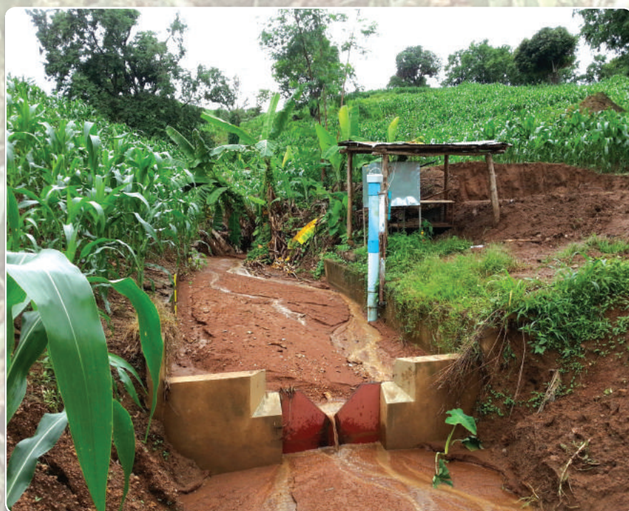
ภาพที่ 8, ตะกอนดินที่ไหลลงเขื่อน ที่เกิดจากการทำไร่ข้าวโพด
