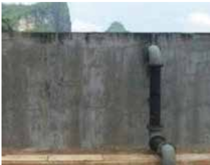
ถังพักน้ำ ขนาดความจุ ๒๗๕ ลูกบาศก์เมตร
