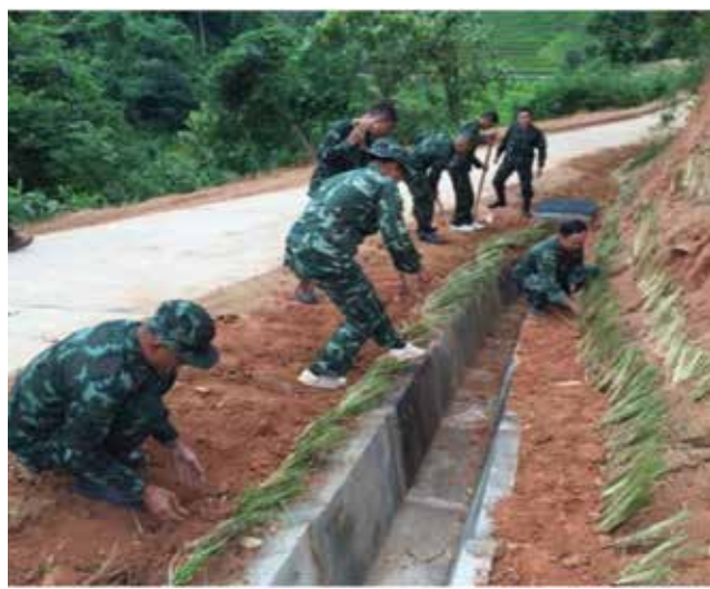
หน่วยงานชุดปฏิบัติการที่ ๑ และชุดปฏิบัติการที่ ๒ จัดกำลังพล ดำเนินการปลูกหญ้าแฝกเพิ่มเติมในพื้นที่ลาดชันบริเวณรางระบายน้ำ โดยดำเนินการปลูกในลักษณะรูปตัววี
