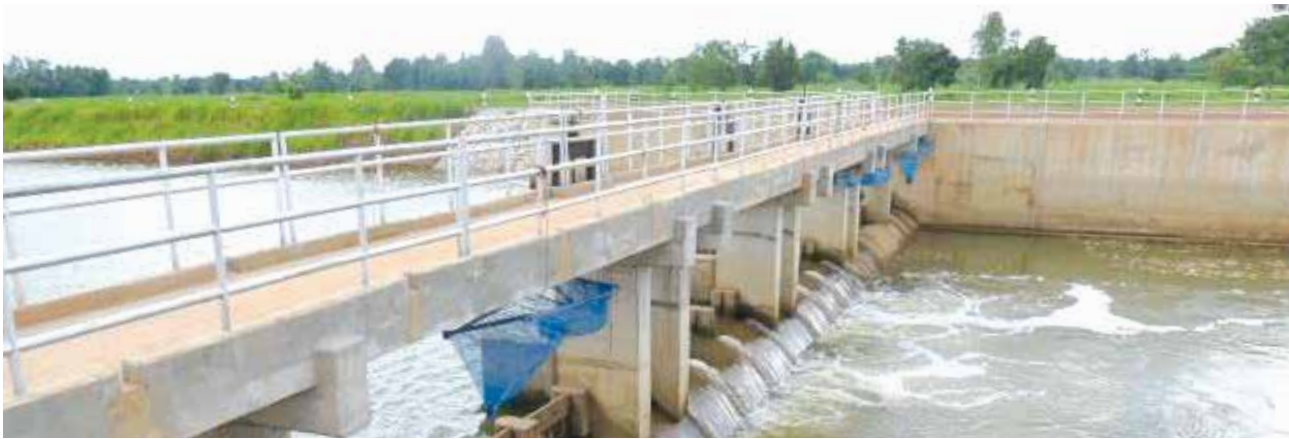
ฝายห้วยช้างก่อสร้างแล้วเสร็จ
