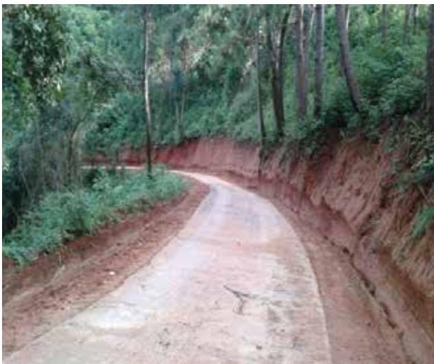
ดำเนินงานก่อสร้างถนนคอนกรีตเสริมเหล็ก กว้าง ๓ เมตร ยาว ๗ กิโลเมตร หนา ๐.๑๕ เมตร ไหล่ทางกว้างข้างละ ๐.๕๐ เมตร (แบบ ทบ.๗๙๔๓)
