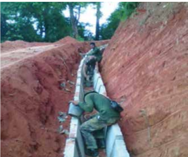
ดำเนินการวางรางระบายน้ำ รูปตัว V ในพื้นที่ที่มีความลาดชันมาก รวมระยะทาง ๘๕๐ เมตร
