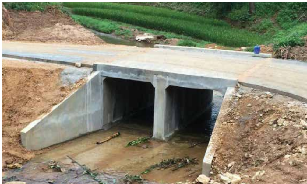
งานก่อสร้าง BOX CULVERT ท่อลอดเหลี่ยม ๒ ช่อง
