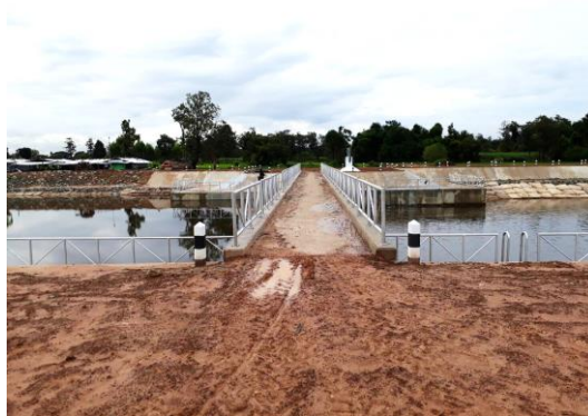
อาคารฝายทดน้ำ
